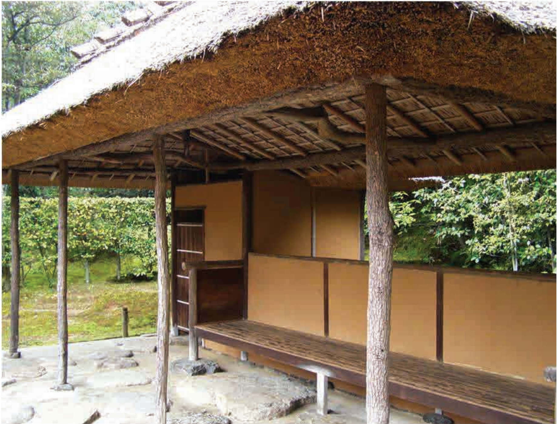
Fig 9.9 Bajo cubierta palos distintos se retuercen, un par arriostran las correas y otros dos apuntalan la cumbre.
