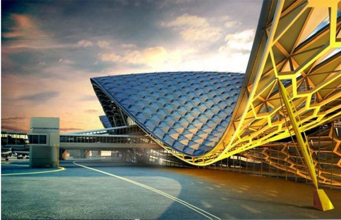
Figura: 2.12. Una estructura como esta es difícilmente modelable con un sistema BIM actual, al menos de una forma suficientemente eficaz como para que sea viable su diseño y ejecución. En cambio, con una herramienta especializada, es posible definir todas sus partes. Propuesta para el Aeropuerto Internacional de Danang por Dang Tran Tuan Anh. Fuente: < http://www.grasshopper3d.com/photo/danang-international-airport-5 >. Acceso 10 oct. 2015.
