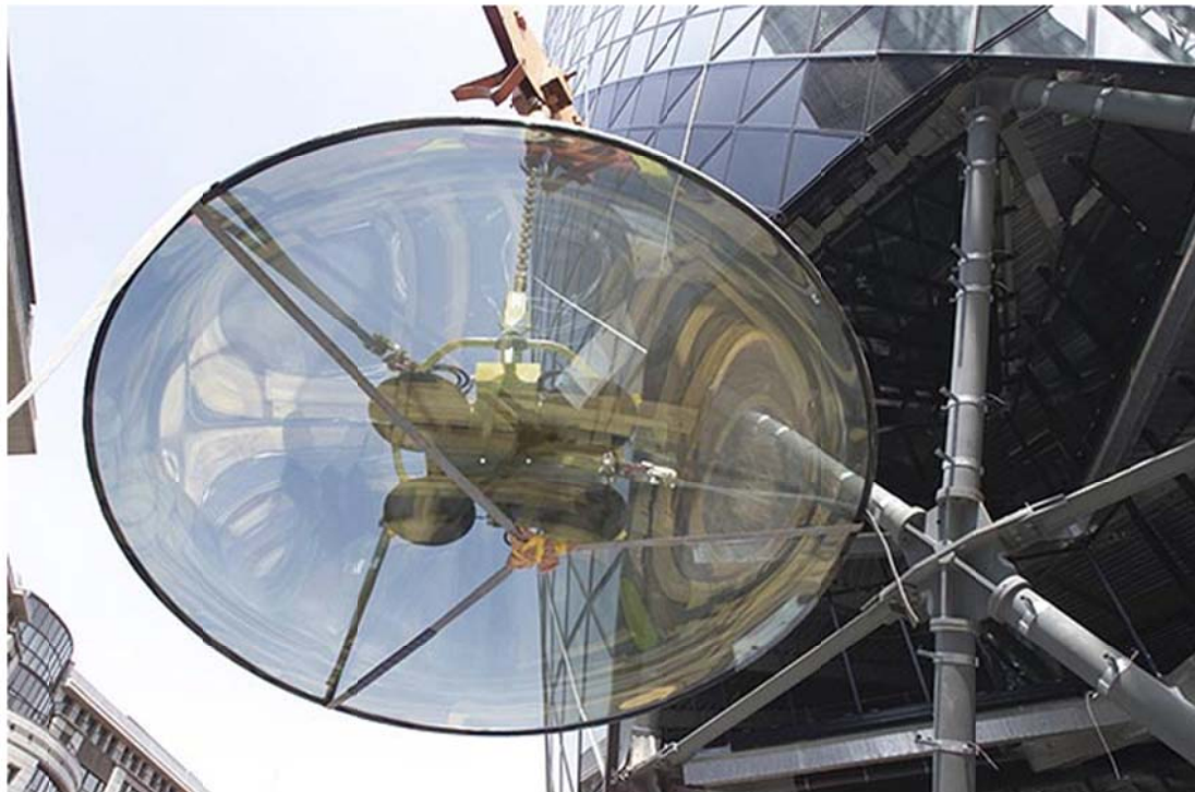
Figura 6.73. Vista del cristal curvo de recubrimiento y remate del óculo central de la cúpula. Fuente: Internet.
