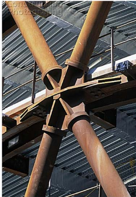
Figura 6.79. Detalle del encuentro estructural en nodo de la rejilla diagonal de acero tubular. Los marcos estructurales en "A" vienen montados de taller. Fuente: Internet.
