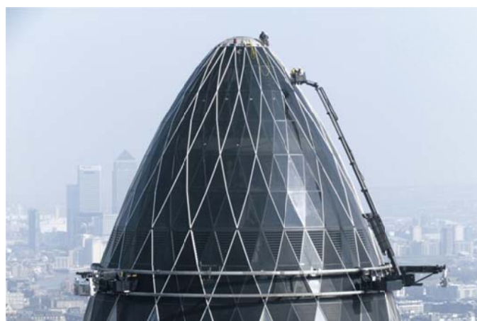
Figura 6.100. Detalle de los dos anillos perimetrales metálicos dispuestos en la cúpula de la edificación que sirven para la ubicación de un dispositivo móvil con plataforma telescópica, para la limpieza y mantenimiento de la torre. Fuente: Internet.
