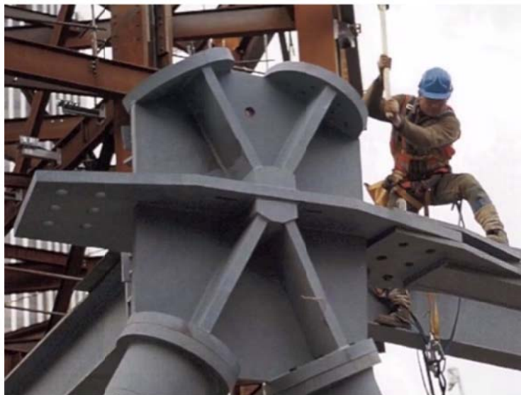
Figura 6.78. Detalle del nodo estructural metálico. Ha sido minuciosamente diseñado para el ensamble con el resto de la estructura, para su unión con el resto de los encuentros con los otros marcos estructurales en "A". Esta pieza viene montada en taller. Fuente: Internet.
