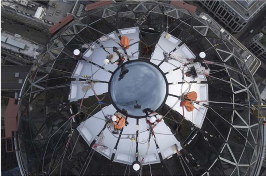
Figura 6.74. Vista en planta del detalle de remate de la zona superior de la cúpula de la torre con la disposición del remate acristalado del óculo de la cúpula. Fuente: Internet.
