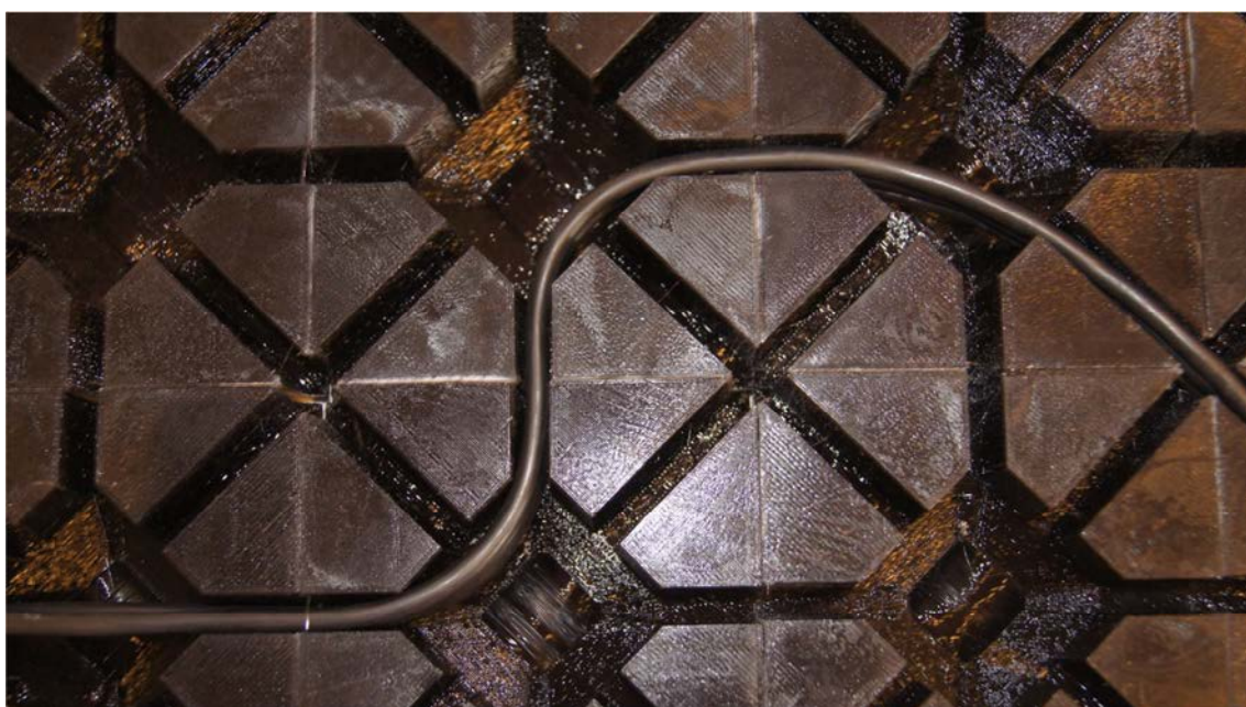
Fig. 64. Vista de de la col·locació d'un traçat curvilini de 3 conductors de Ø6mm sobreposats sobre el prototip
