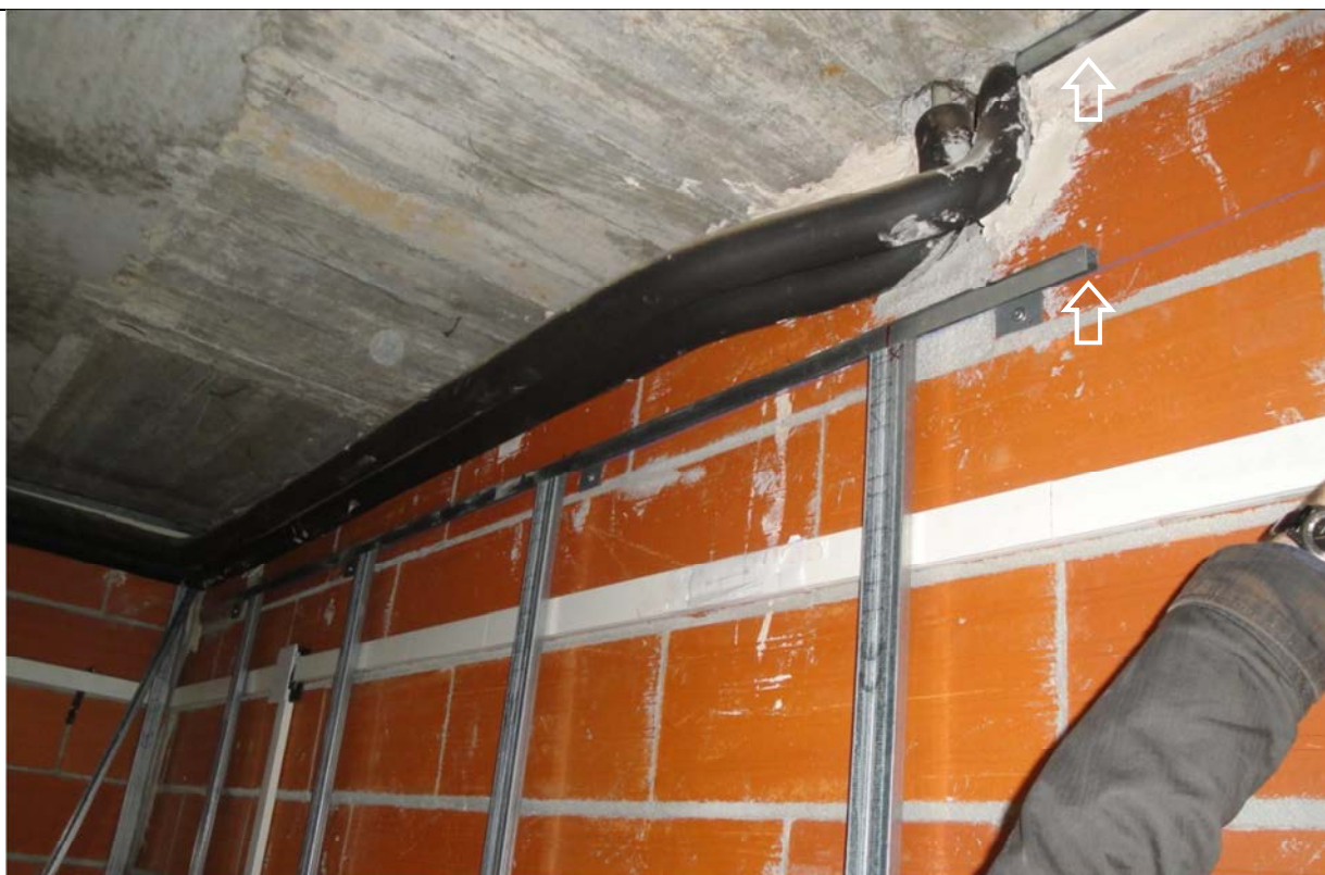
Fotografia 3: Canals de Knauf. Cas particular de retirament per adaptació als tubs presents a l'obra.
