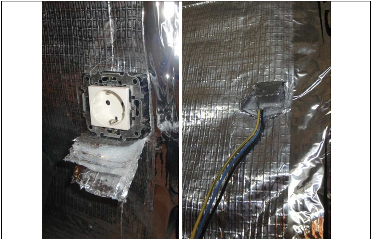
Fotografia 29: Talls en l'aïllament reflectant per deixar pas a les instal·lacions.
