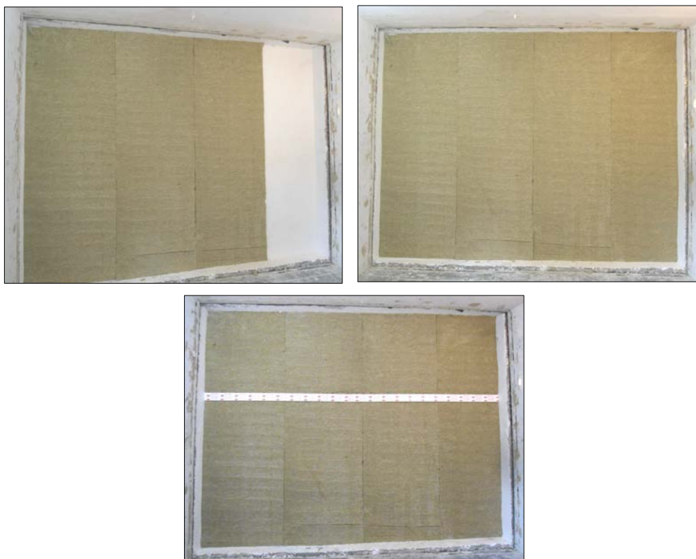
Imágenes 5 a 7 Colocación de la lana de roca y la canalización para instalaciones cableadas
