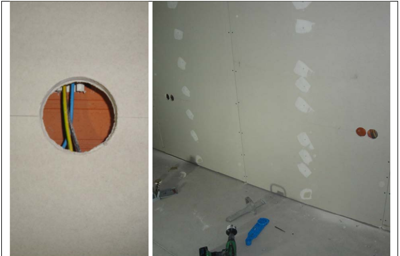
Fotografia 11: Perforació amb corona de les PYL.
