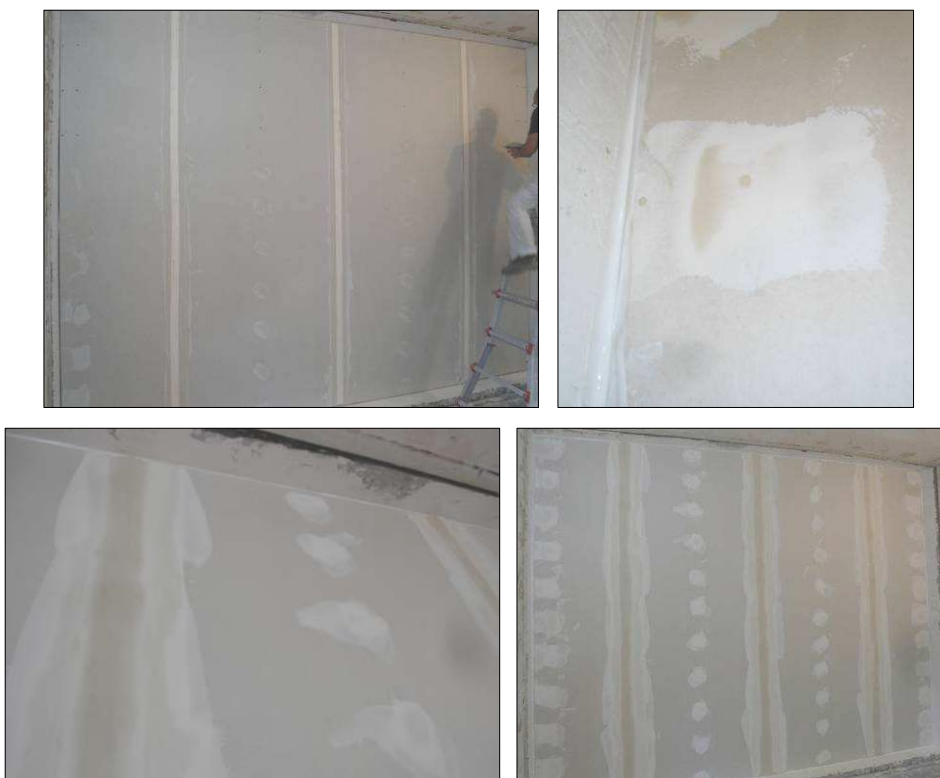
Imágenes 39 a 42 Proceso de sellado de las juntas entre PYL y entre PYL y marco portamuestras
