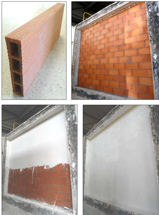
Imágenes 1 a 4 Ladrillo hueco simple utilizado y proceso de construcción de la pared de base
