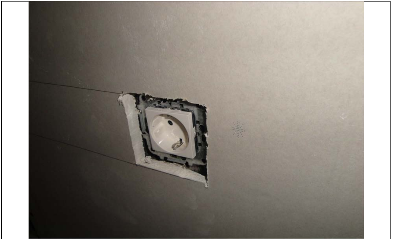
Fotografia 33: Endoll sobre la paret de l'aïllament reflectant.
