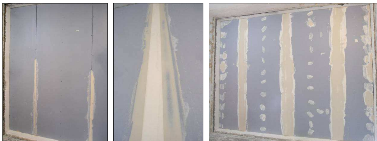
Imágenes 49 a 51 Proceso de sellado de las juntas entre PYL
