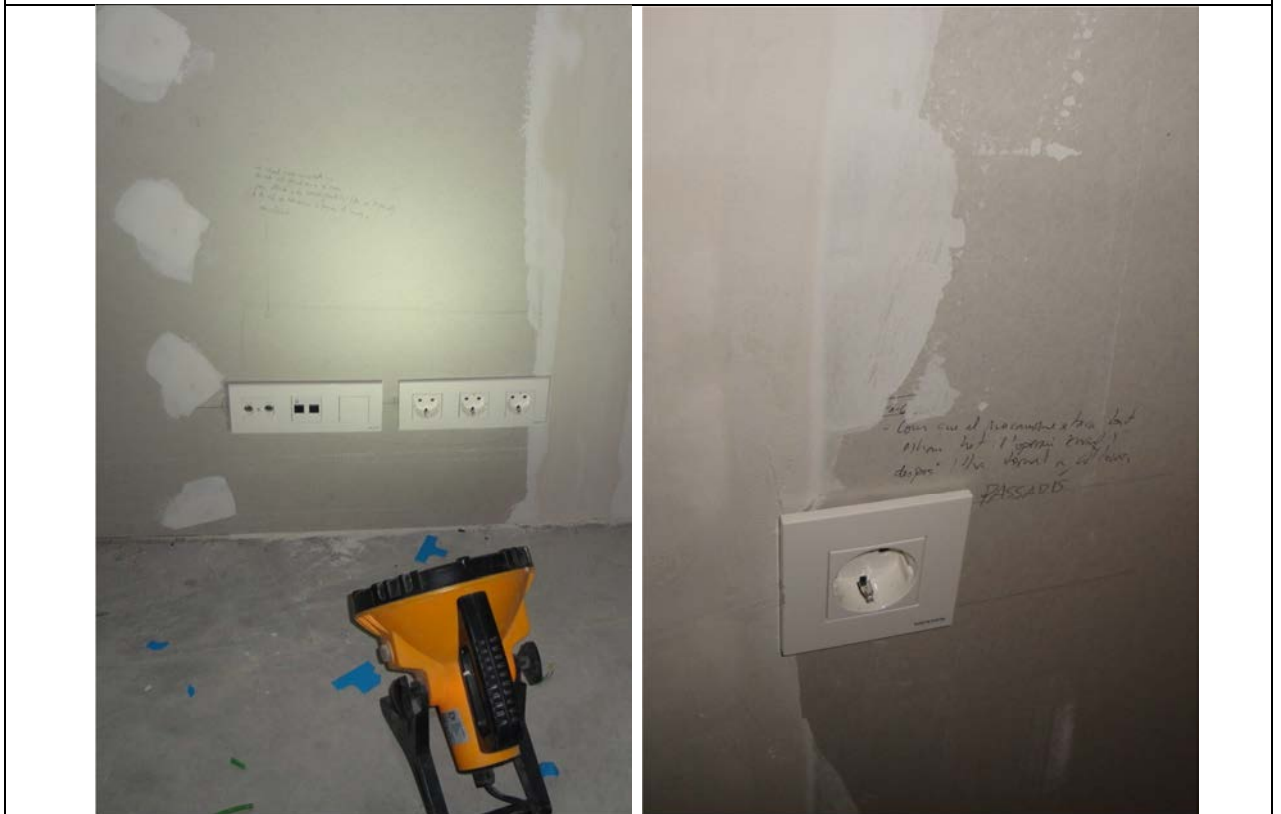
Fotografia 21: Mecanismes instal·lats de la primera iteració.
