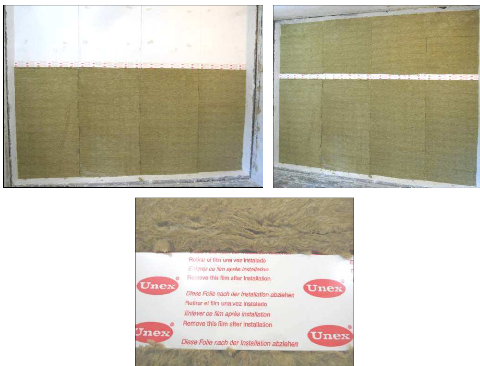
Imágenes 14 a 16 Colocación de la lana de roca en una de las caras de la pared de base
