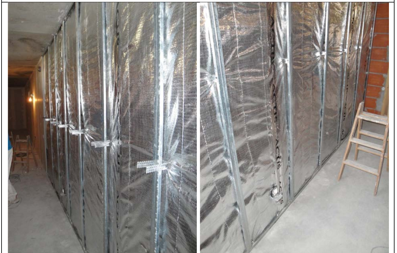
Fotografia 32: Muntants sobre aïllament reflectant.
