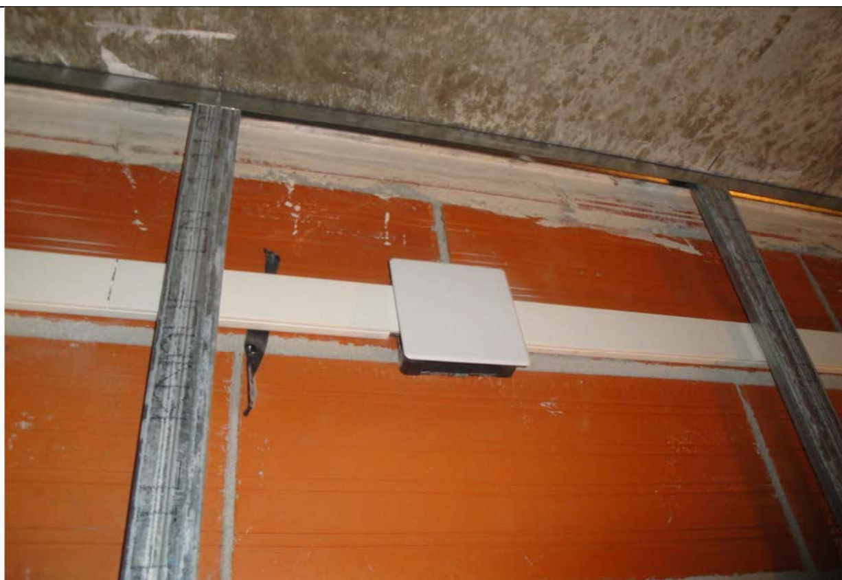
Fotografia 8: Caixetí ocult utilitzat per empalmar el cablejat de dues canaletes.
