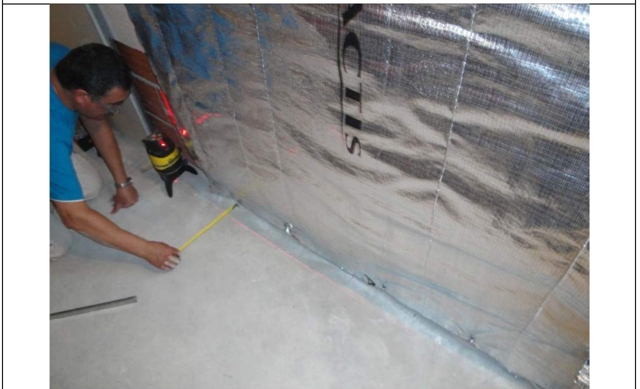
Fotografia 30: Replanteig del revestiment PYL degut al augment de gruix per la col·locació de l'aïllament reflectant.
