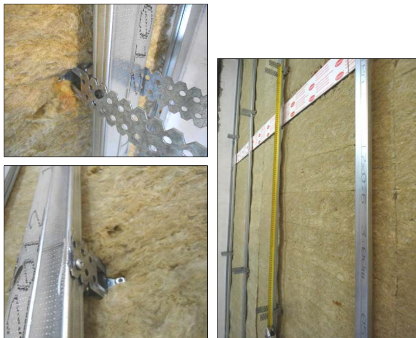
Imágenes 27 a 29 Detalle de los perfiles de arriostramiento y distancia entre ellos
