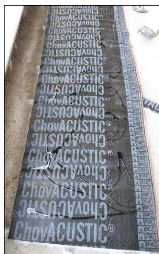
Imágenes 32 a 36 Compuesto multicapa y su adhesión a las PYL
