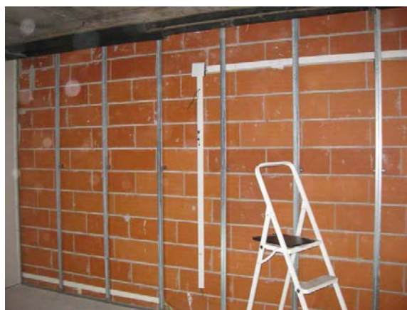
Nou procediment d'instal·lacions integrades en canals i revestides per aplacats (NPI)
