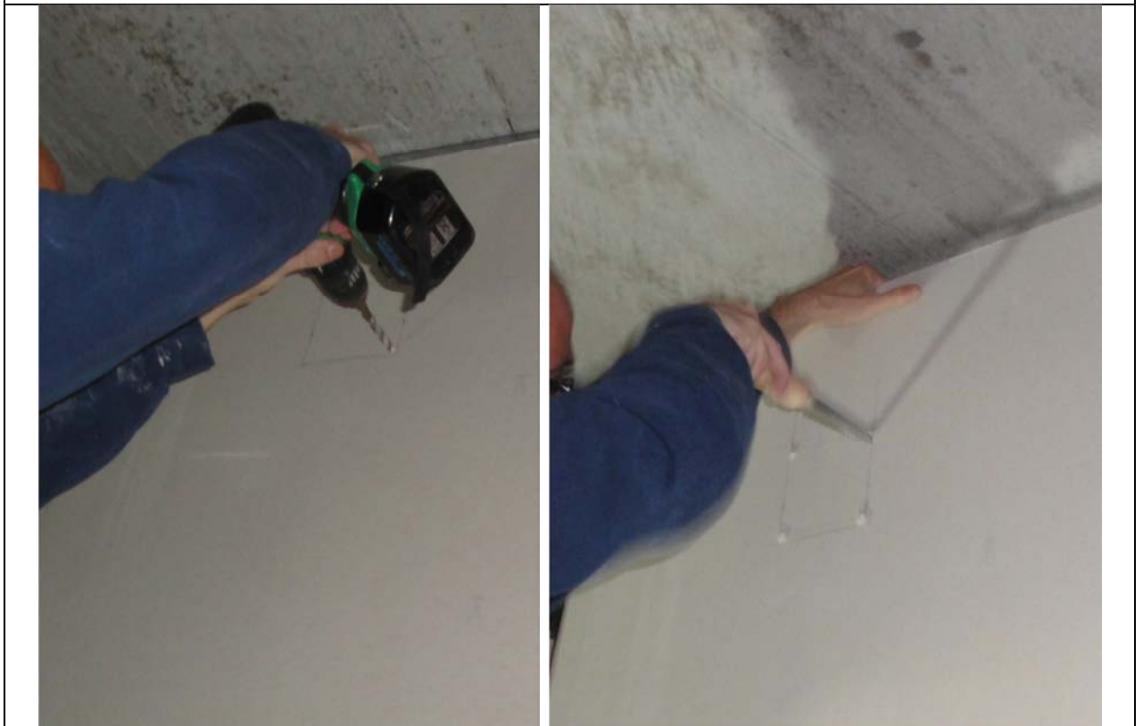
Fotografia 14: Perforació de la placa.
