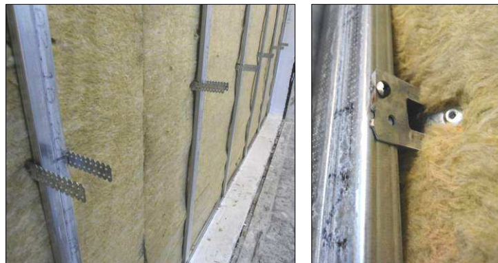
Imágenes 26 a 28 Colocación de los perfiles de arriostramiento
