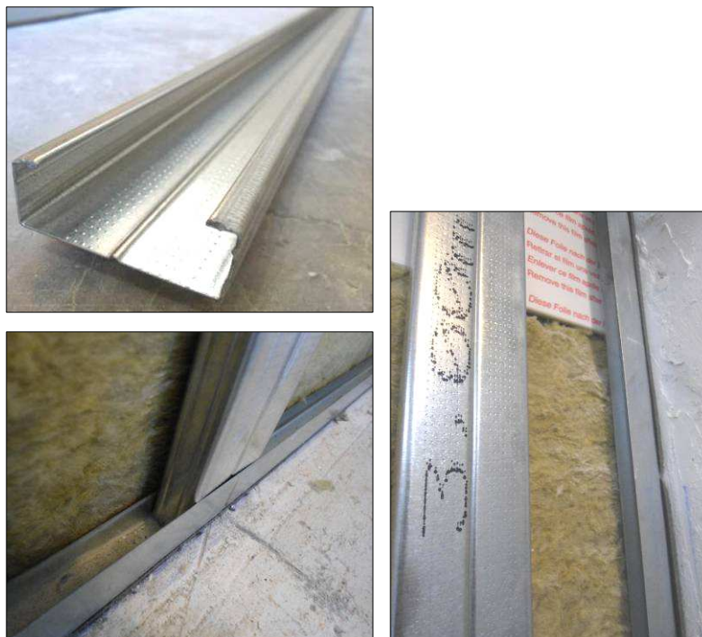
Imágenes 21 a 23 Perfil en C empleado como montante y su instalación
