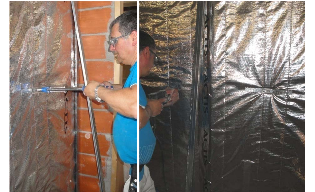
Fotografia 31: Instal·lació dels muntants sobre l'aïllament reflectant.
