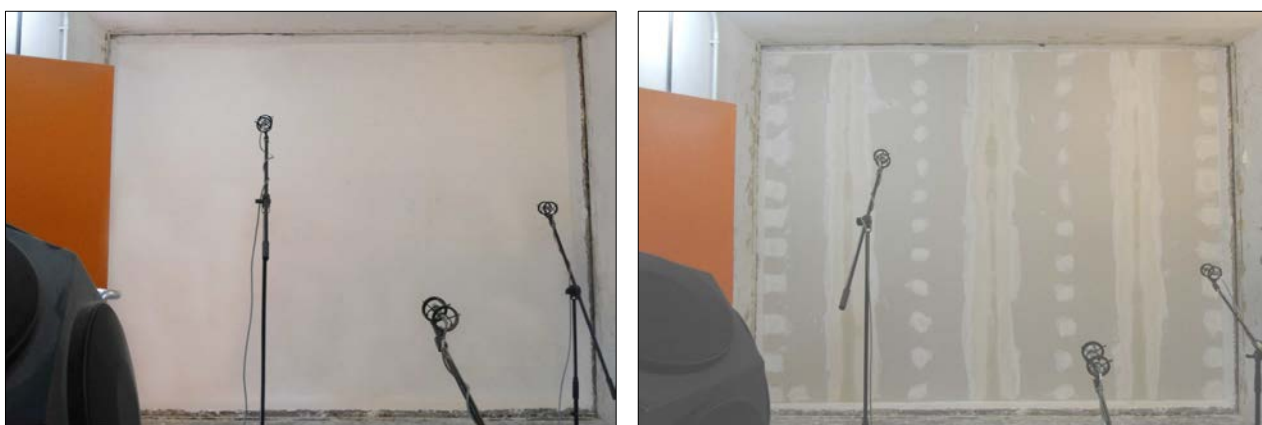
Imágenes 25 y 26 Pared de base sin y con el trasdosado, respectivamente, lista para ensayo
