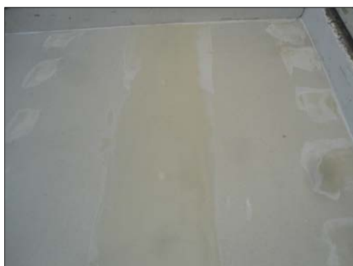
Imágenes 20 a 23 Proceso de sellado de las juntas entre PYL y entre PYL y marco portamuestras
