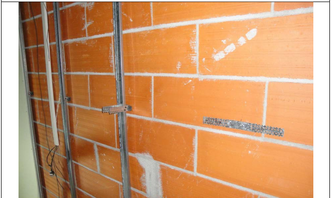
Fotografia 2: Mestres de Knauf fixades al suport.
