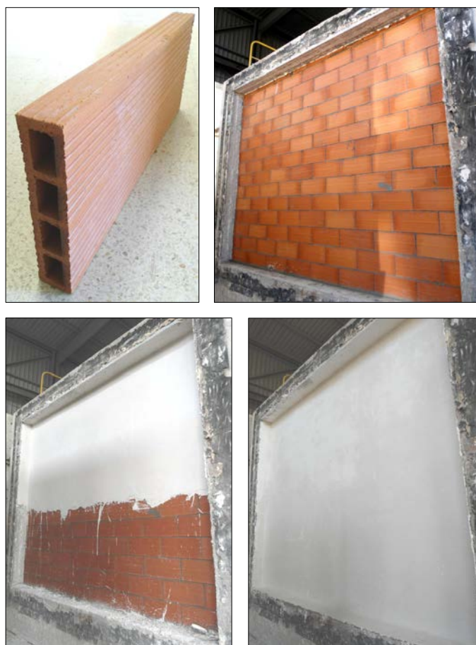
Imágenes 1 a 4 Ladrillo hueco simple utilizado y proceso de construcción del tabique
