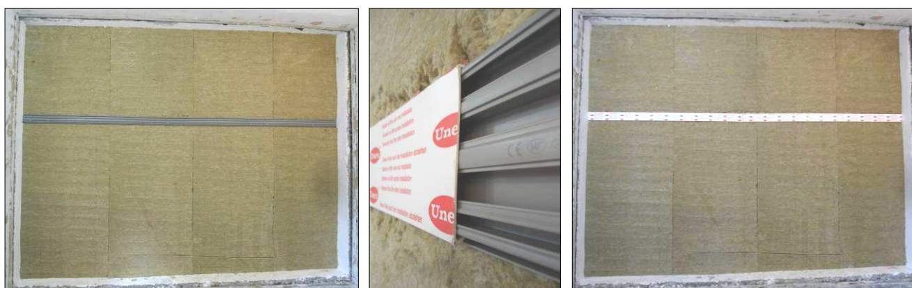
Imágenes 11 a 15 Detalle y colocación de la canalización para instalaciones cableadas
