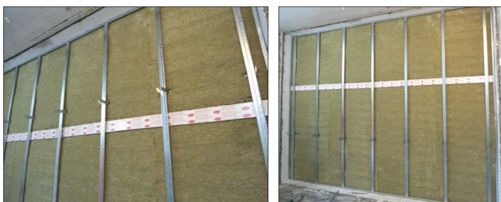
Imágenes 8 y 9 Instalación de la estructura autoportante
