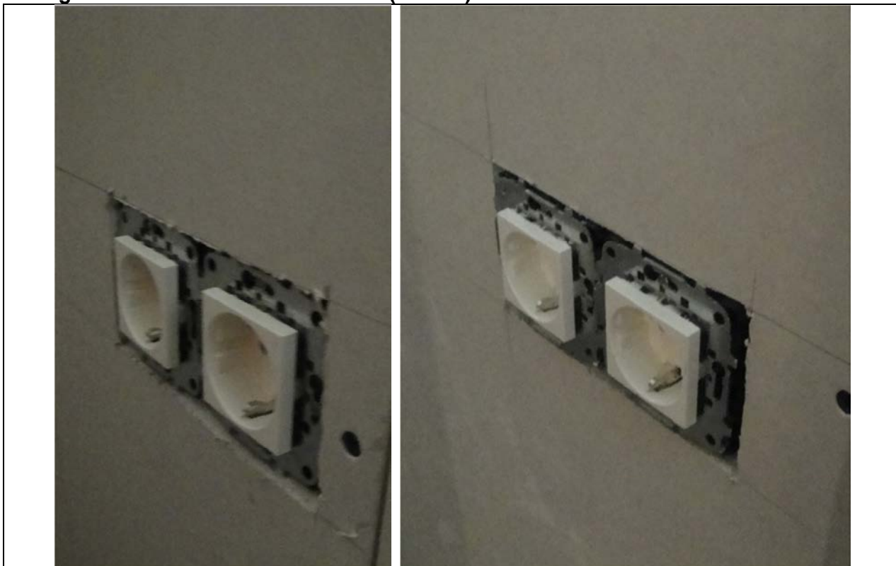
Fotografia 27: Mecanismes de la cuina. Paret que haurà d'anar enrajolada.
