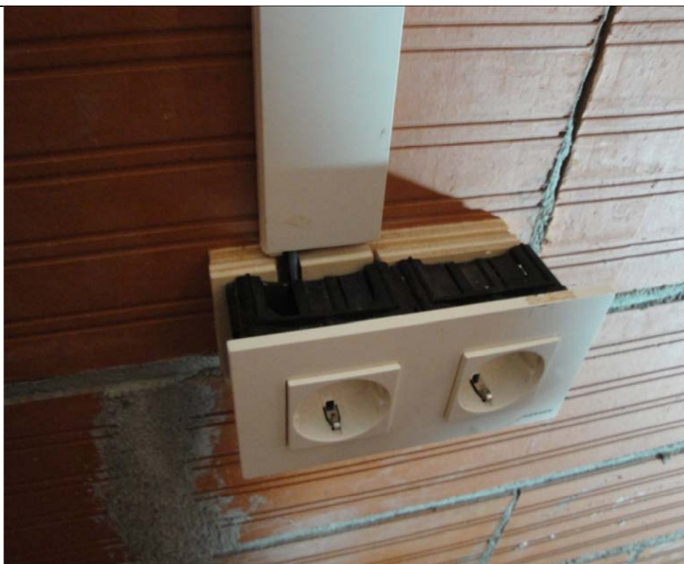
Fotografia 24: Suport de fusta tallat per passar els cables.
