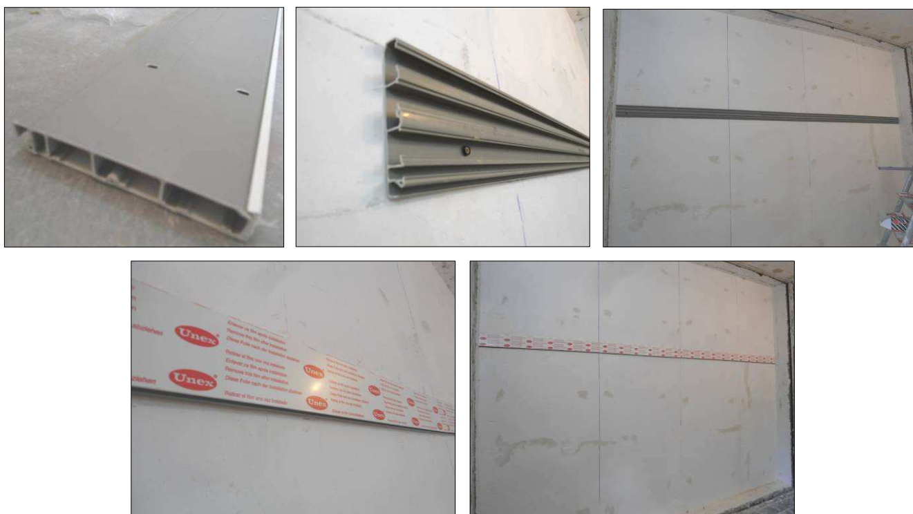
Imágenes 5 a 9 Detalle y colocación de la canalización para instalaciones cableadas
