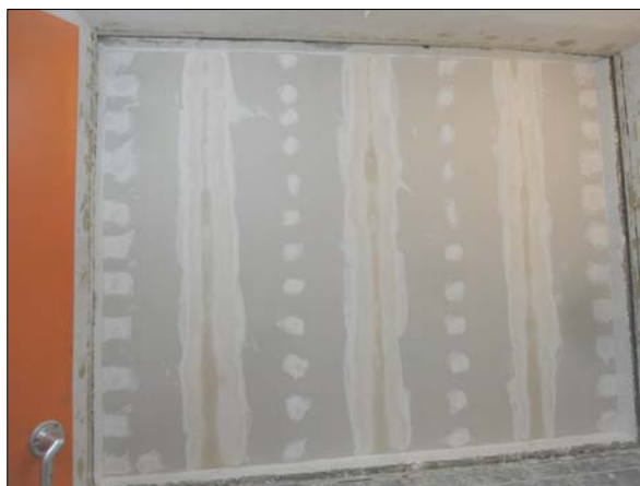
Imagen 24 Placas de yeso una vez terminado el sellado
