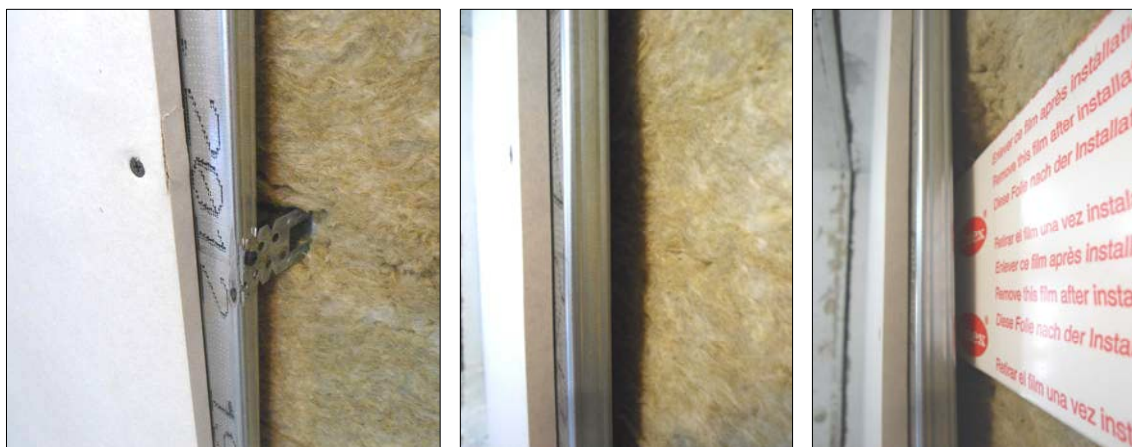
Imágenes 34 a 36 Detalles de la instalación de las PYL
