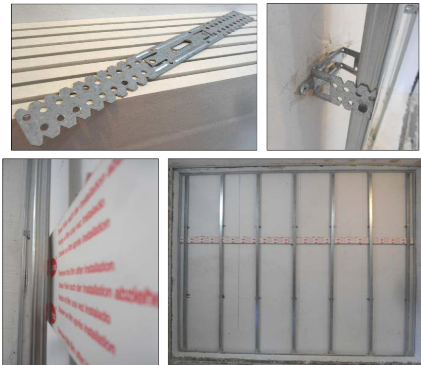
Imágenes 9 a 12 Perfil utilizado para el arriostramiento y su instalación
