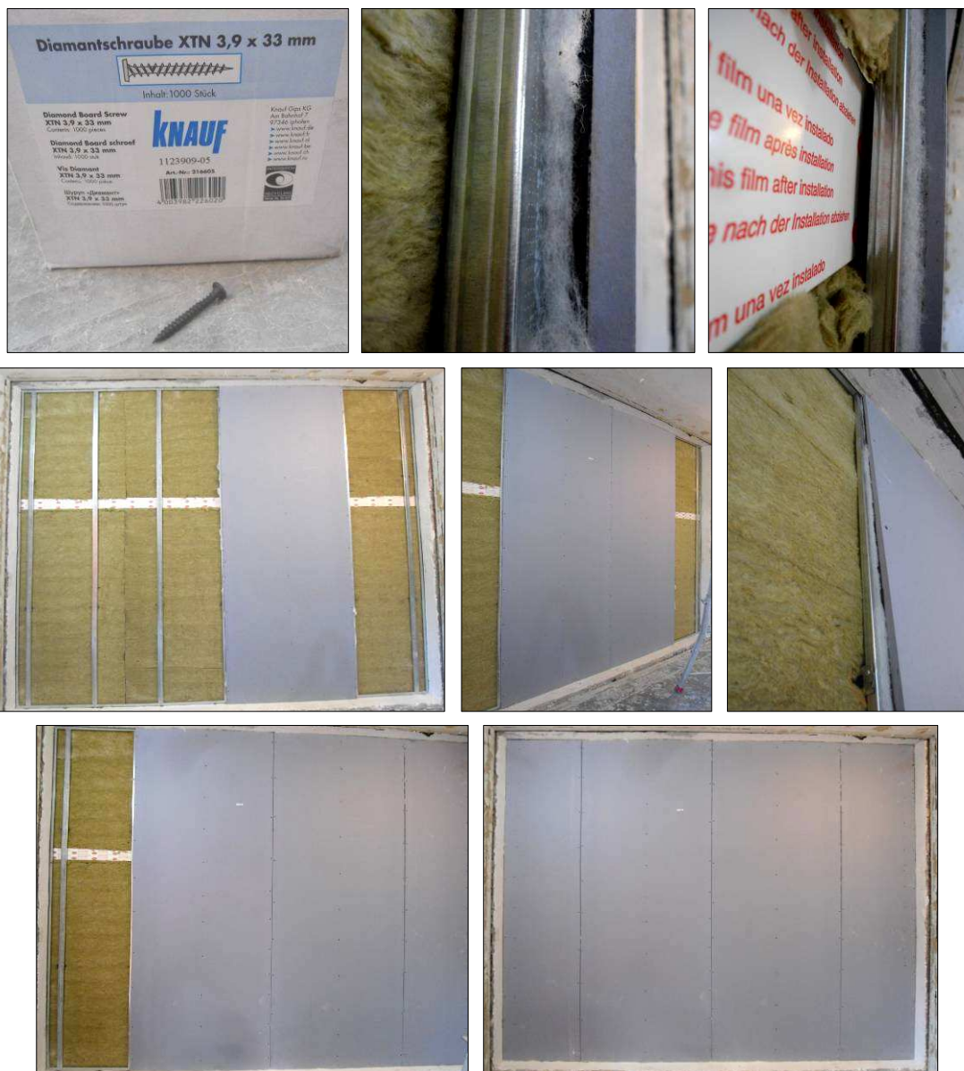
Imágenes 39 a 46 Tornillería utilizada e instalación de las PYL
