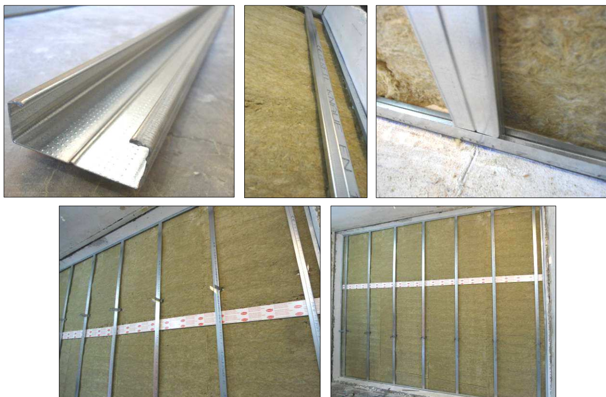
Imágenes 20 a 24 Perfil en C empleado como montante y su instalación
