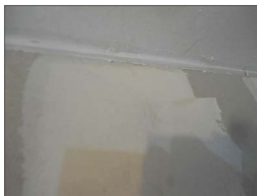
Imágenes 20 a 23 Proceso de sellado de las juntas entre PYL y entre PYL y marco portamuestras
