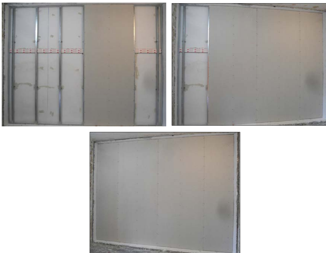
Imágenes 15 a 17 Colocación de las PYL
