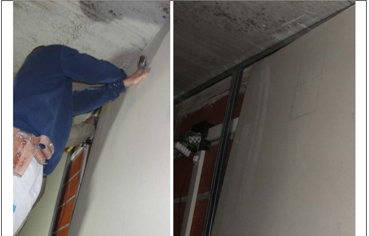
Fotografia 13: Mides i posició del caixetí passades a la placa.
