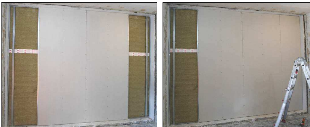
Imágenes 32 y 33 Colocación de las PYL
