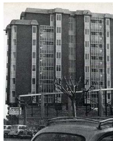
176. Edifício de habitação em Barcelona, MBM - Martorell, Bohigas, Mckay ( Summa nº 20, 1969)
