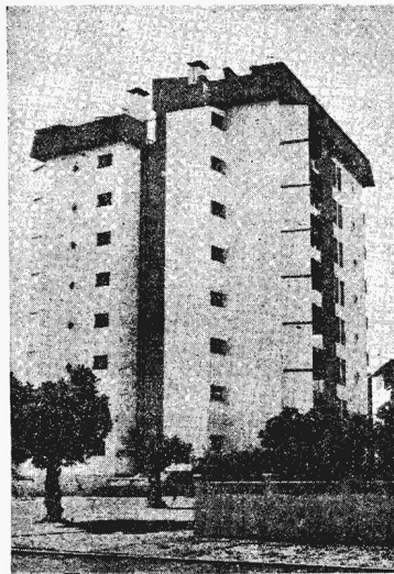
Rua General Gomes Freire, n.º 55 e 55-A. O prédio ficou para a história da arquitectura portuguesa
