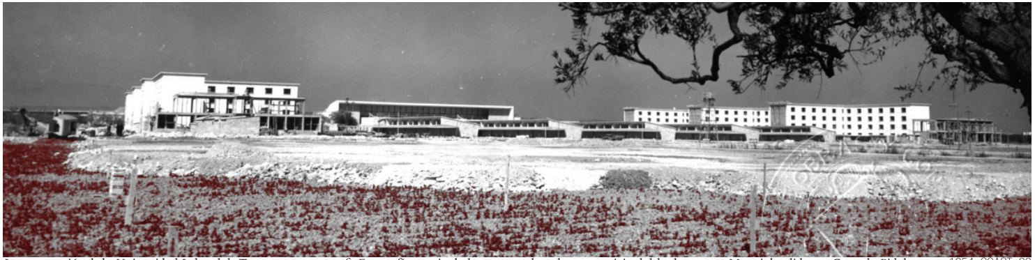
La construcción de la Universidad Laboral de Tarragona, 1952-1956. Fotografía manipulada para resaltar el terreno original del sobrepuesto. Material cedido por Gonzalo Pidal
