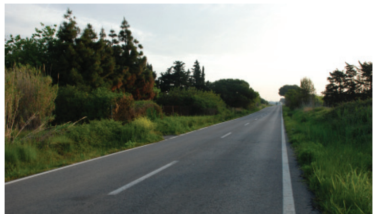
Carretera La Pineda - Tarragona. Antiguo Camí Vell de Salou
