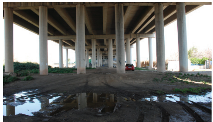
Viaducto del eje transversal sobre Entrevías-Clasificación
