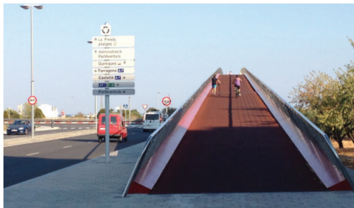
Vila-seca. Vista del puente peatonal sobre la A-7
