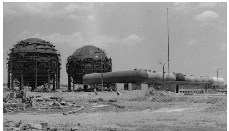
Butano S.A. Construcción de la factoría
