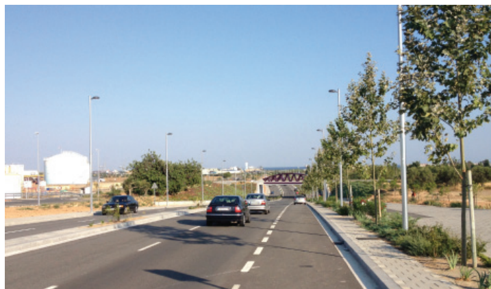
Vista del nuevo Raval de Mar entre Vila-seca y La Pineda
