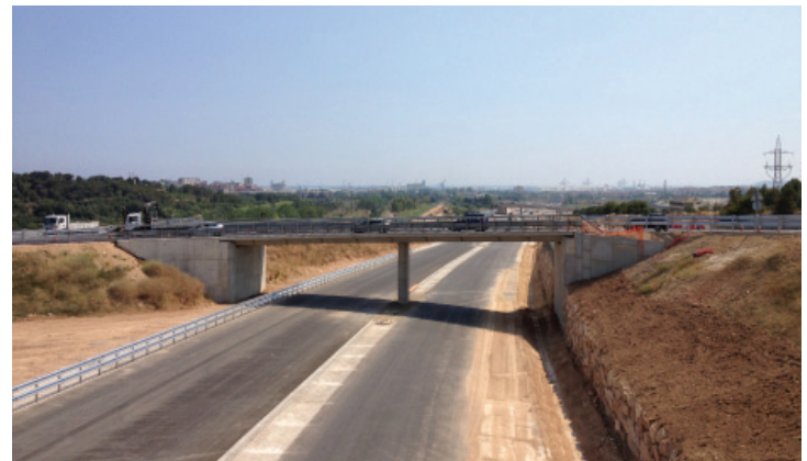
A-27 en construcción. Prolongación del eje transversal
