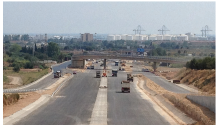
Construcción de la A-27
