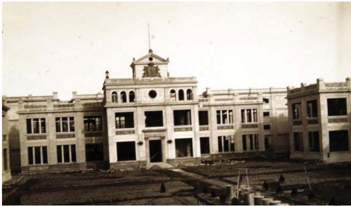
Tabacalera. Vista de la fachada en obras
