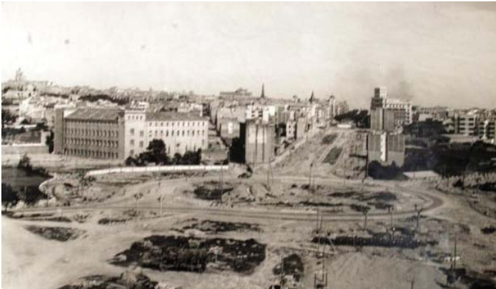
Plaza Imperial Tárraco. Obras de urbanización
