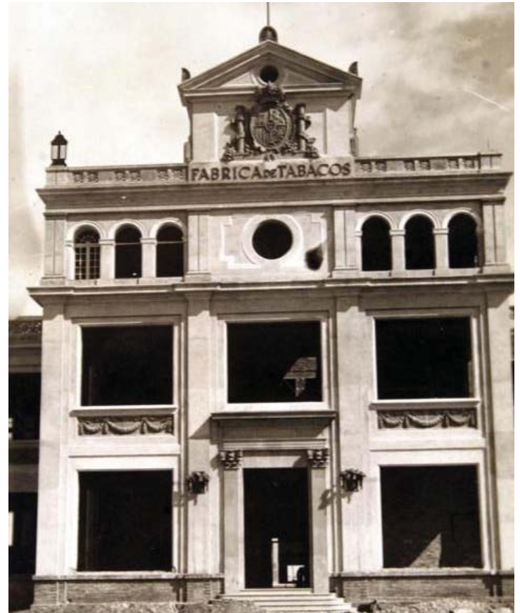
Tabacalera. Vista de la fachada en obras
