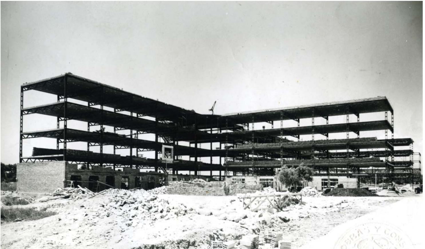
La construcción de la Universidad Laboral de Tarragona
