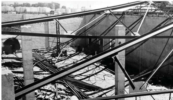
Polígono Entrevías. Vista de una nave industrial 1958_AAJP_01
