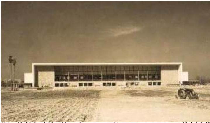
Universidad Laboral. Vista del comedor en construcción
