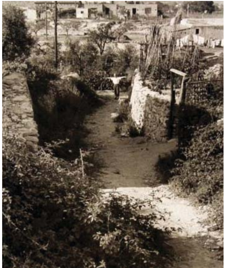
Torreforta. Calle en construcción
