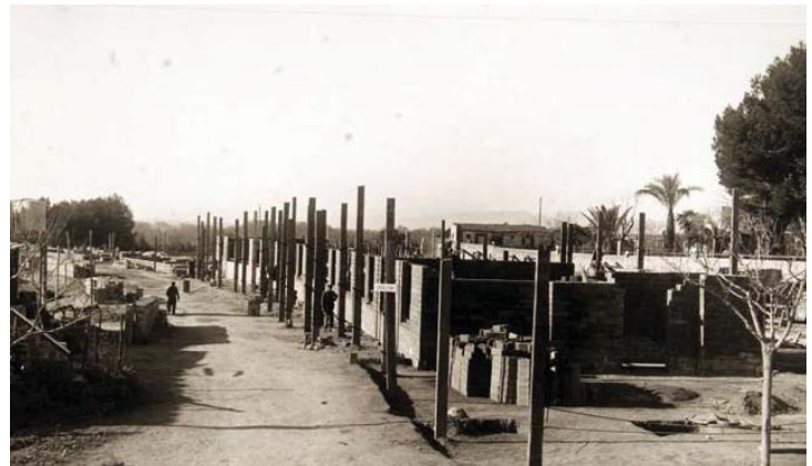
Casa Bloc. Construcción de las viviendas
