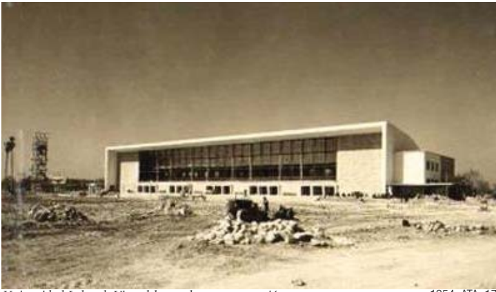
Universidad Laboral. Vista del comedor en construcción
