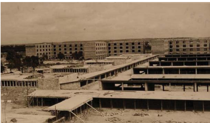
Universidad Laboral. Construcción de las aulas
