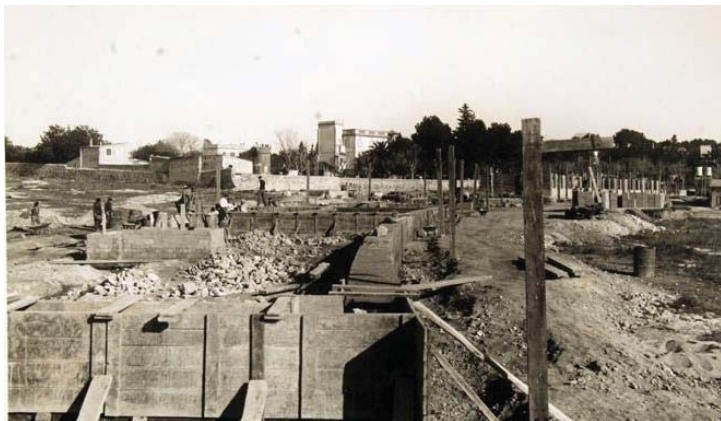
Casa Bloc. Construcción de las viviendas
