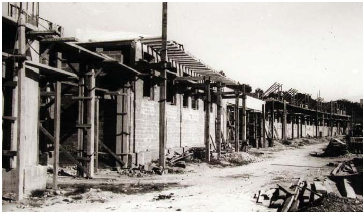
Casa Bloc. Construcción de las viviendas
