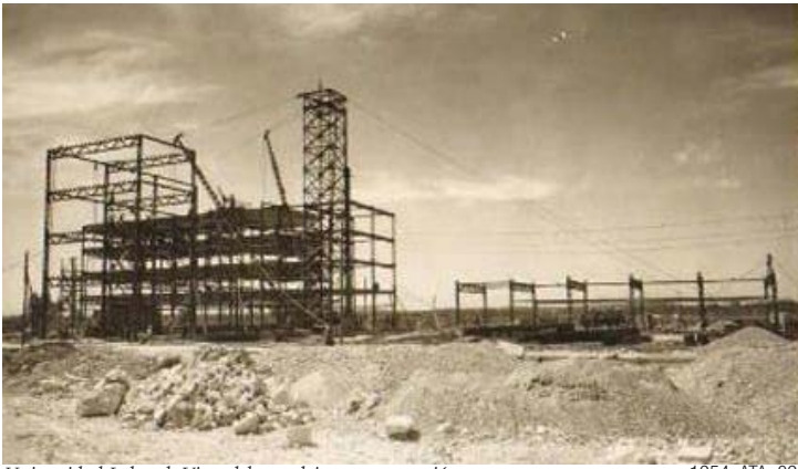
Universidad Laboral. Vista del complejo en construcción
