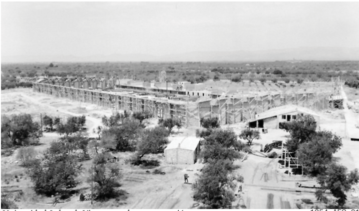
Universidad Laboral. Vista general en construcción
