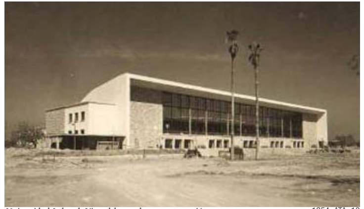
Universidad Laboral. Vista del comedor en construcción
