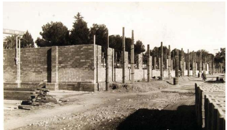
Casa Bloc. Construcción de las viviendas
