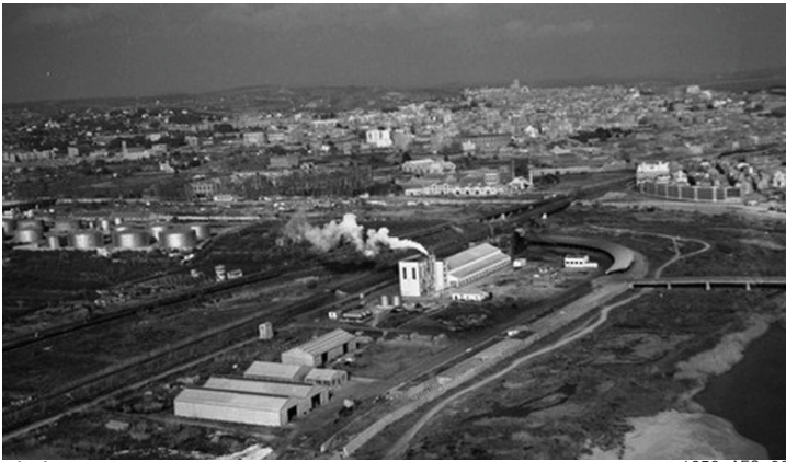
Aliada Química S.A. Vista aérea
