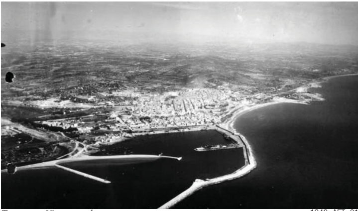
Tarragona. Vista general
