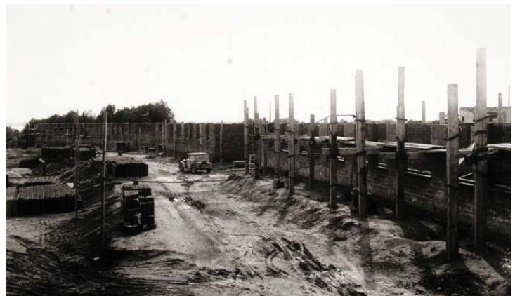
Casa Bloc. Construcción de las viviendas
