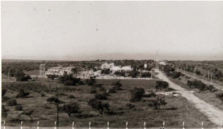
Polígono Francolí. Vista de terrenos y primeras fábricas
