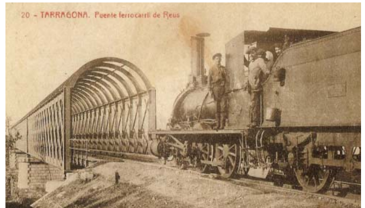
Tarragona. Puente ferrocarril de Reus
