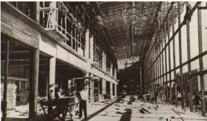
Universidad Laboral. Vista del comedor en construcción
