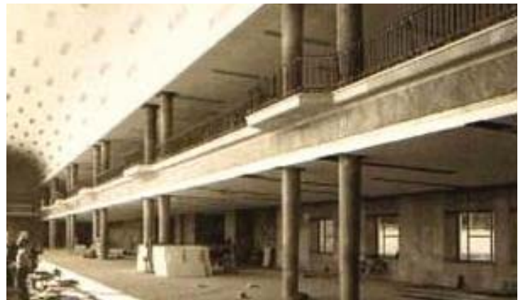
Universidad Laboral. Vista del comedor en construcción
