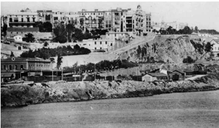
Tarragona. Vista de la estación y bajada del Toro
