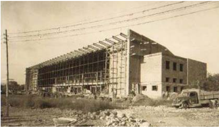
Universidad Laboral. Vista del comedor en construcción
