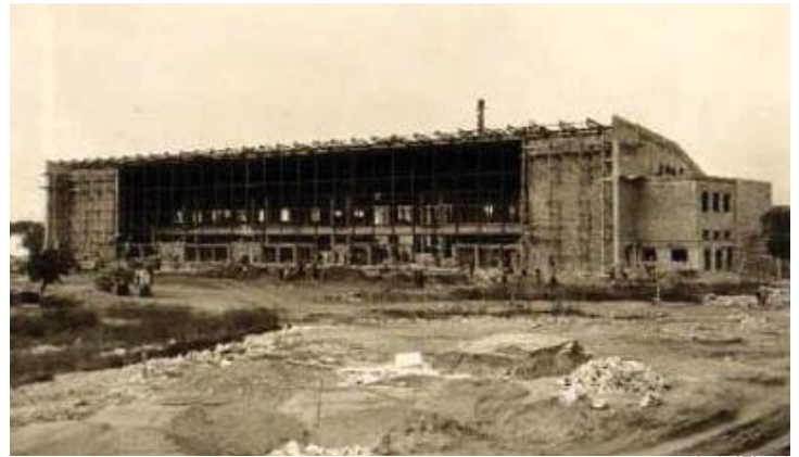
Universidad Laboral. Vista del comedor en construcción
