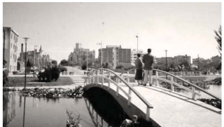
Plaza Imperial Tárraco. Vista del puente
