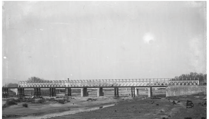
Tarragona. Puente del ferrocarril sobre el río Francolí
