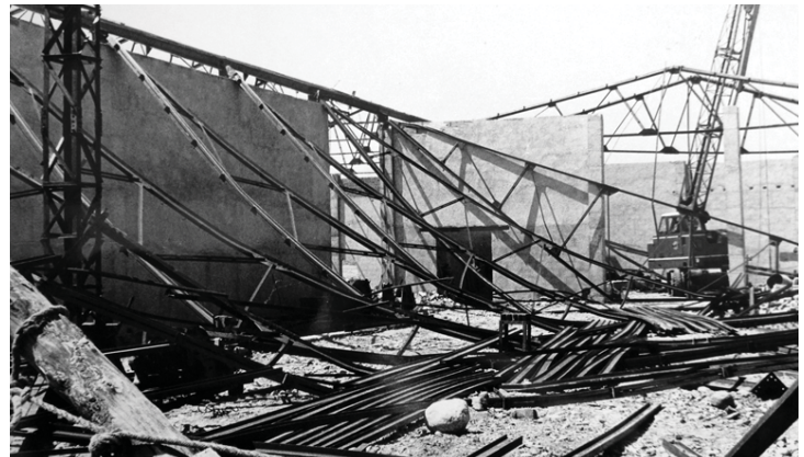
Polígono Entrevías. Vista de una nave industrial 1958_AAJP_02
