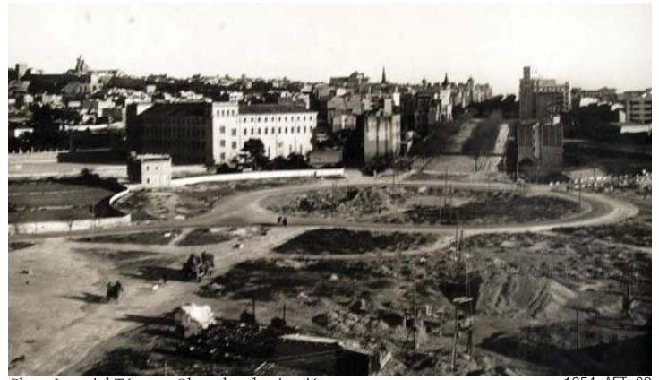
Plaza Imperial Tárraco. Obras de urbanización
