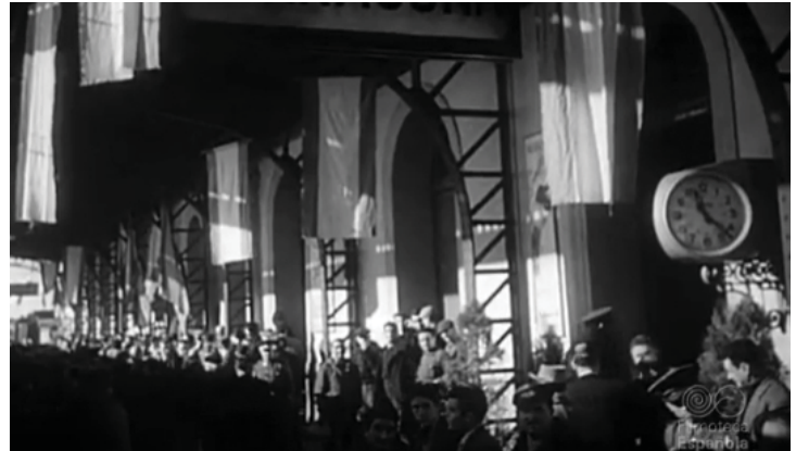
Tarragona. Electrificación del servicio ferroviario
