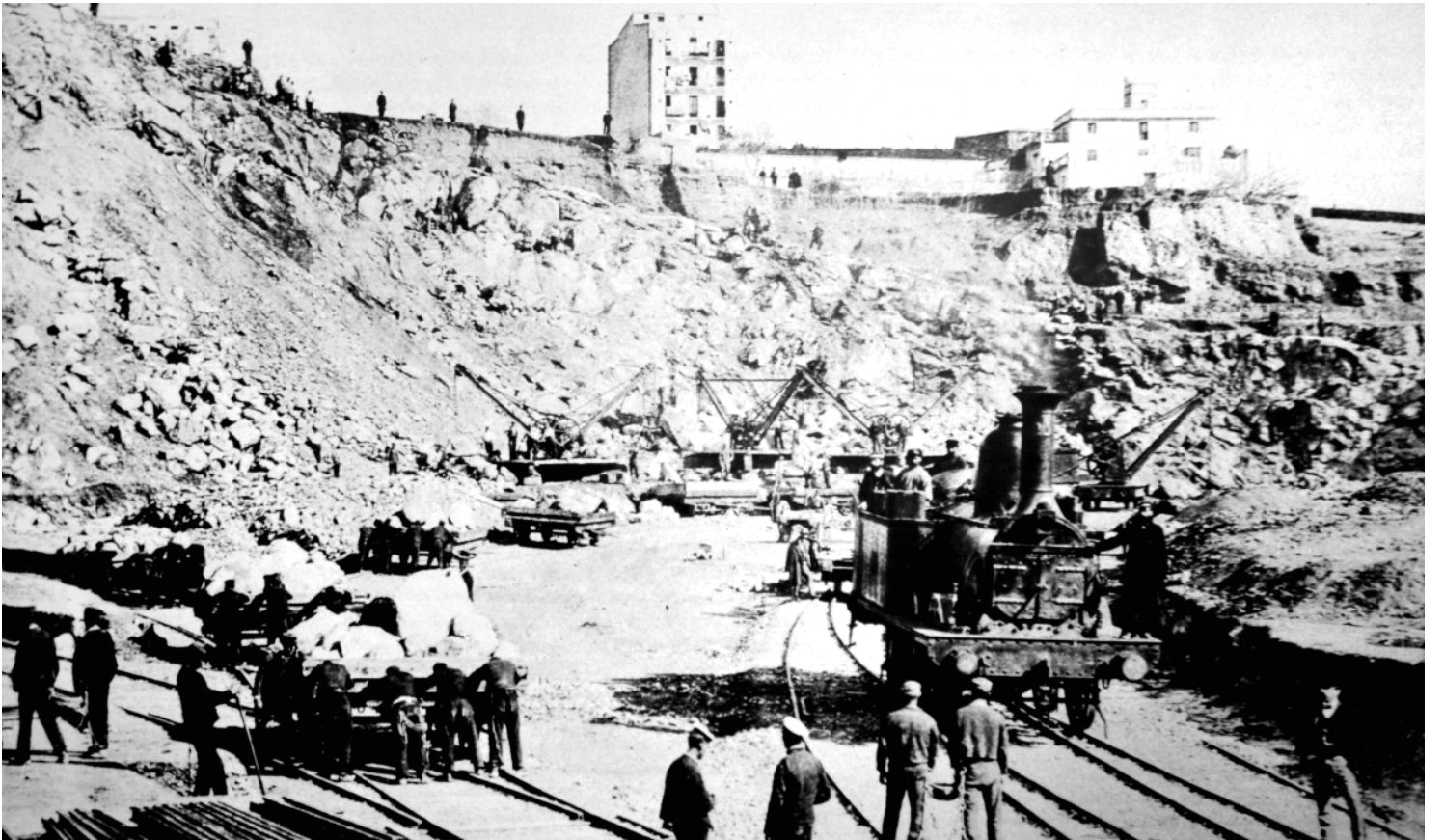
Instantánea de los trabajos en la pedrera cercana al puerto
