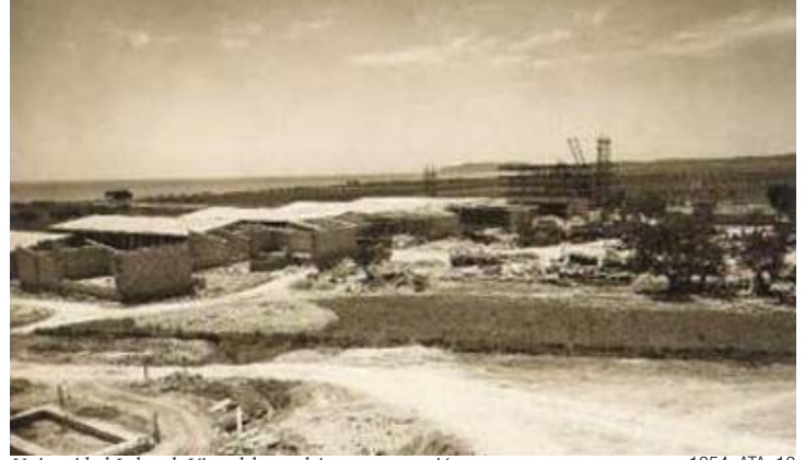
Universidad Laboral. Vista del complejo en construcción
