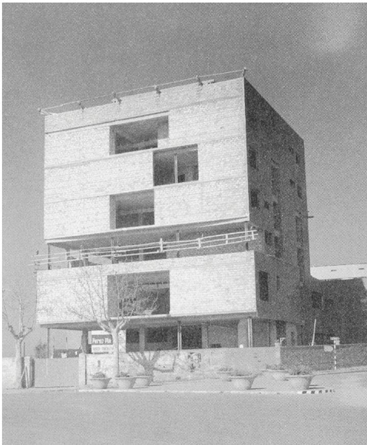
Gobierno Civil. Vista del edificio en construcción
