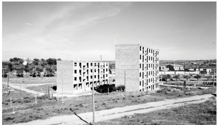
▲ Viviendas en construcción en Torreforta
