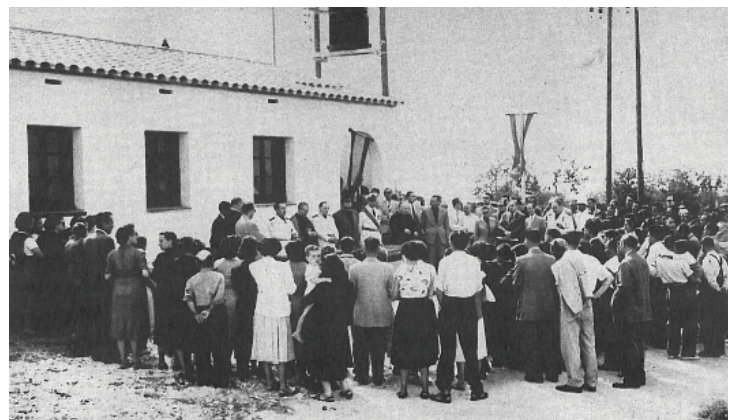
▲ Casas Bajas de Torreforta. Entrega oficial de llaves
