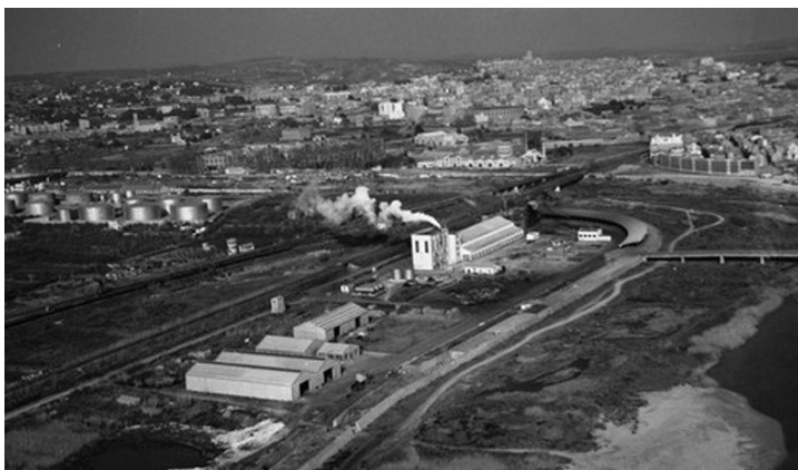
△ Aliada Química S.A. Vista aérea
