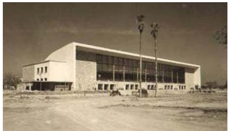
^ Universidad Laboral. Vista del comedor en construcción
