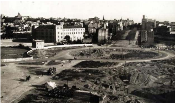
▲ Plaza Imperial Tarraco. Obras de urbanización
