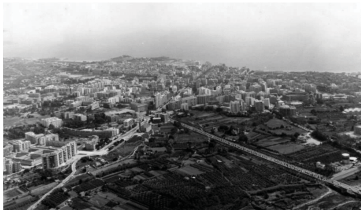
▲ Vista aérea de la avenida de Roma recién construida
