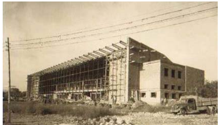
▲ Universidad Laboral. Vista del comedor en construcción
