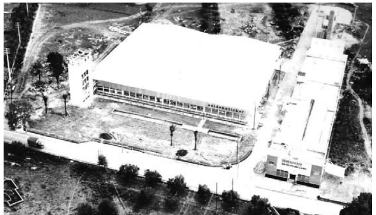
▲ Seidesticker. Vista de la fábrica.
