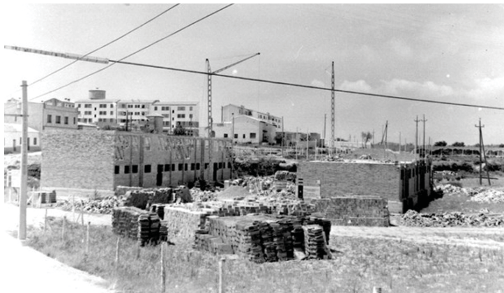
▲ Viviendas en construcción en Torreforta
