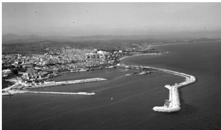
△ Puerto. Vista aérea
