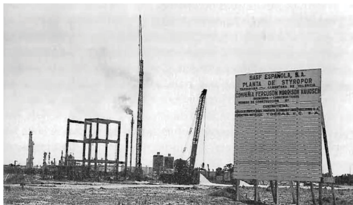
A Basf. Vista de la factoría en construcción
