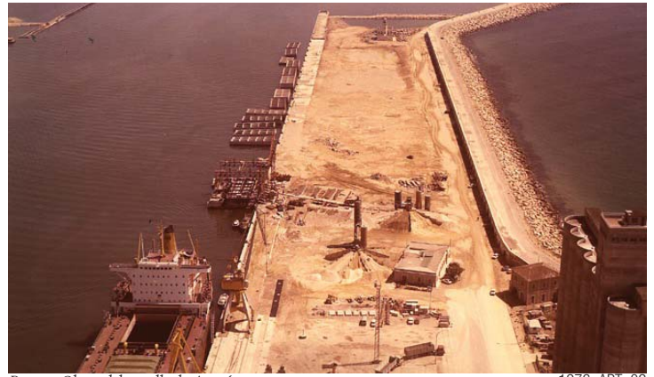
Puerto. Obras del muelle de Aragón
