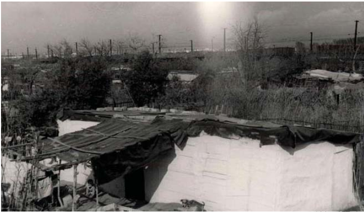
Polígono Entrevías. Barracas en los terrenos
