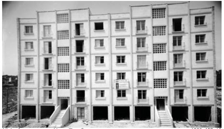
Viviendas en construcción en Torreforta
