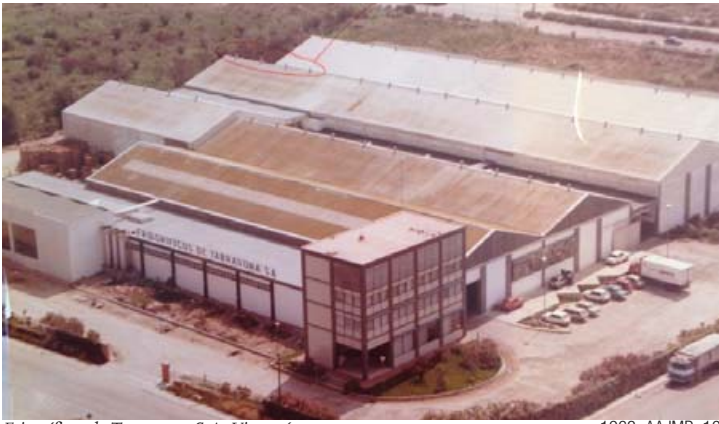
Frigoríficos de Tarragona S.A. Vista aérea
