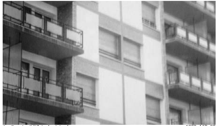
La Granja. Edificio de viviendas
