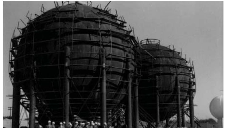
Butano S.A. Construcción de la factoría
