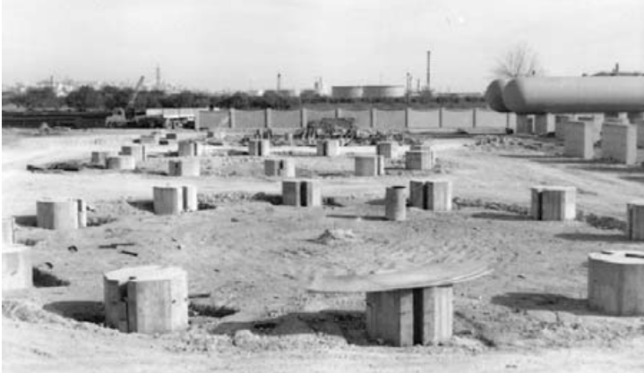
Butano S.A. Construcción de la factoría
