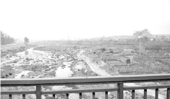
Tarragona. Vista del puente sobre el Francolí
