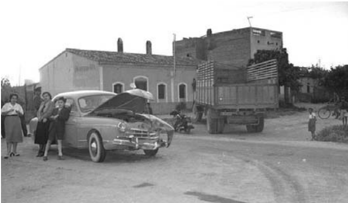
N-340. Accidente en la carretera
