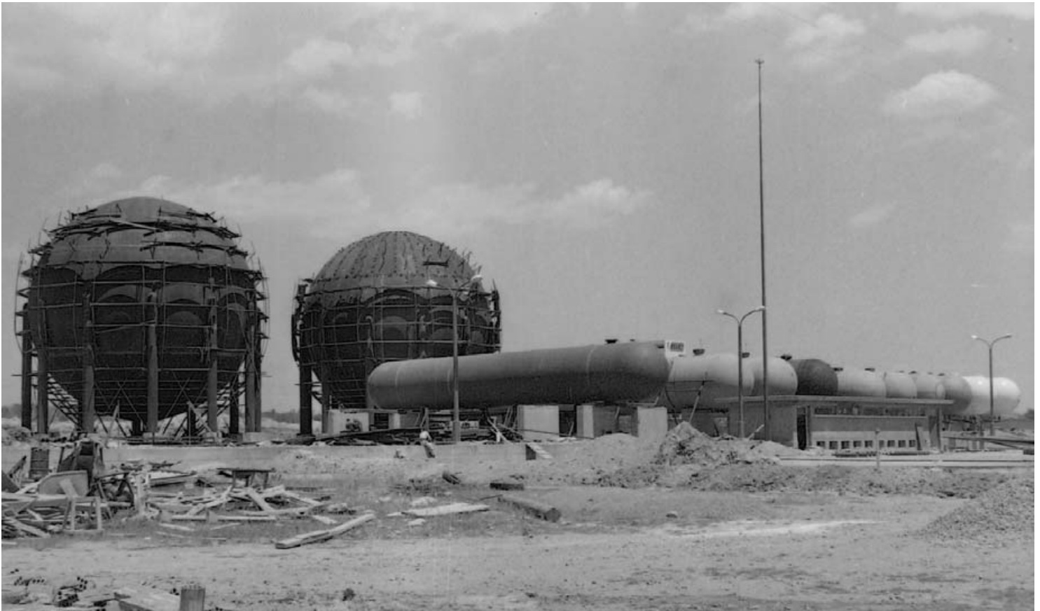
Butano S.A. Construcción de la factoría
