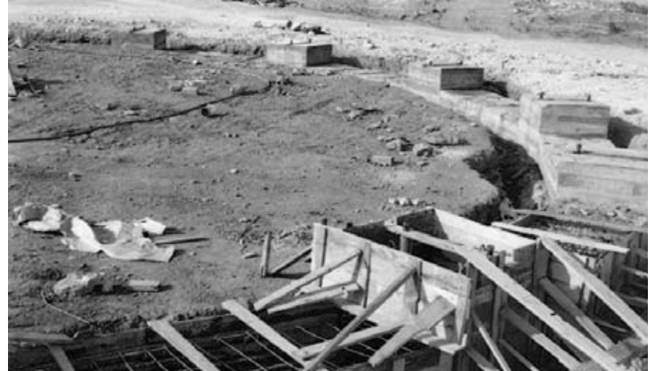
Butano S.A. Construcción de la factoría
