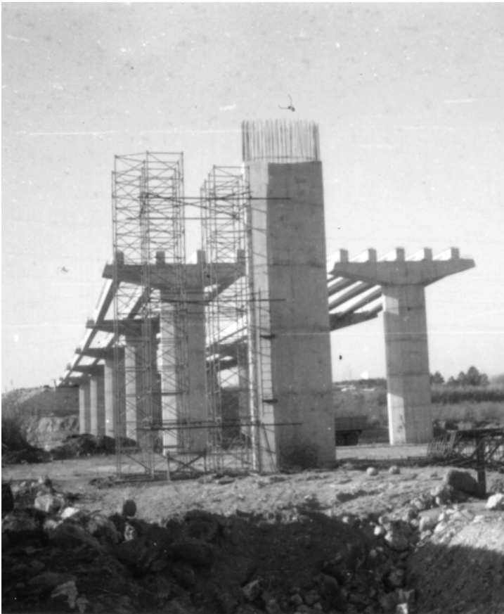
Construcción del viaducto de la autopista sobre el Francolí
