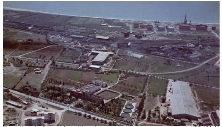
Torrass Herreras Construcciones. Vista aérea
