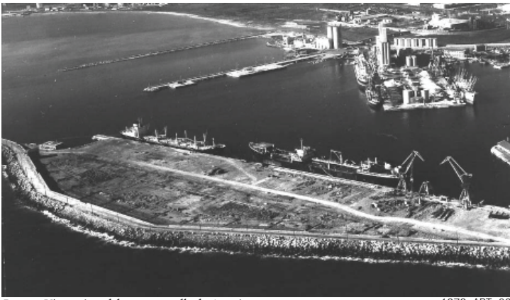
Puerto. Vista aérea del nuevo muelle de Aragón
