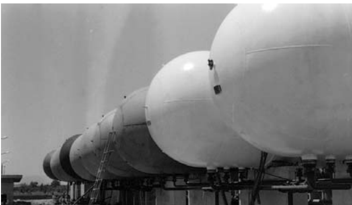
Butano S.A. Construcción de la factoría
