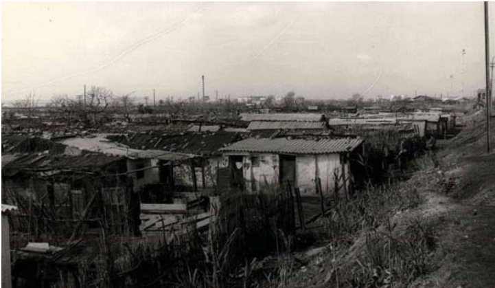
Polígono Entrevías. Barracas en los terrenos
