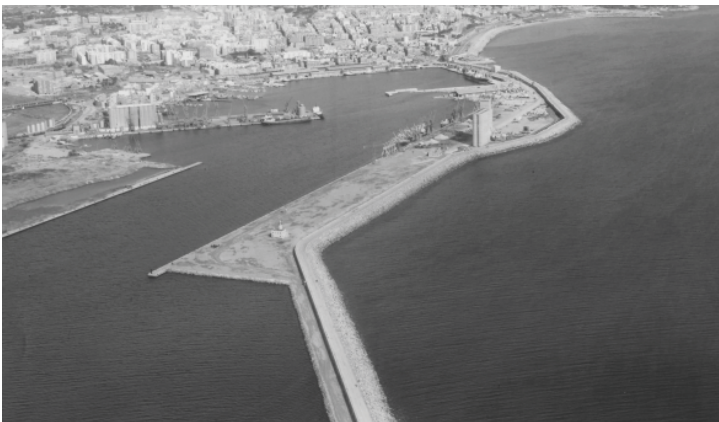
Puerto. Vista aérea del dique de Levante
