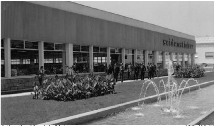
Seidensticker. Vista de la fábrica.
