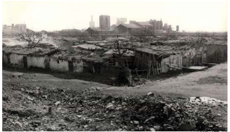
Polígono Entrevías. Barracas en los terrenos
