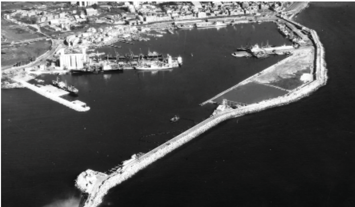
Puerto. Vista aérea de las obras del dique de Levante
