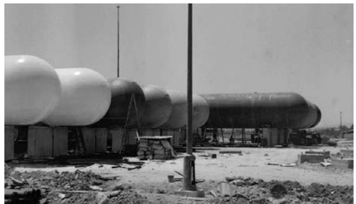
Butano S.A. Construcción de la factoría
