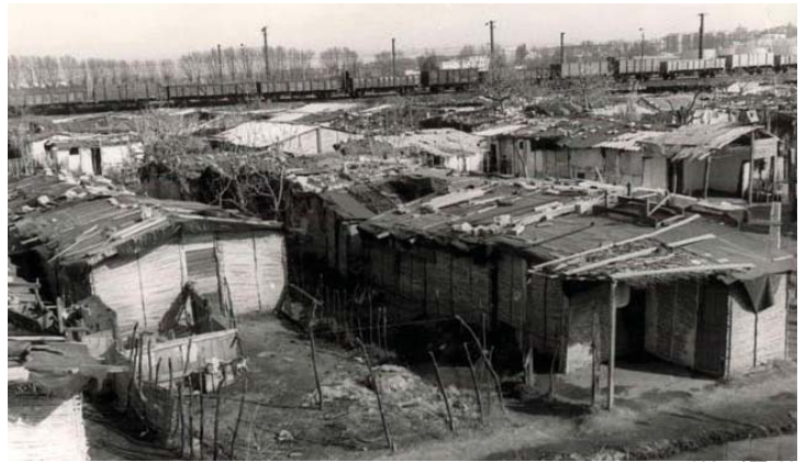
Polígono Entrevías. Barracas en los terrenos
