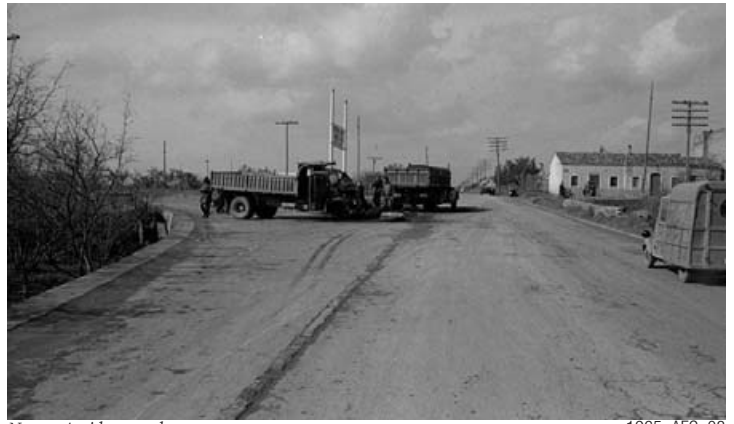
N-340. Accidente en la carretera
