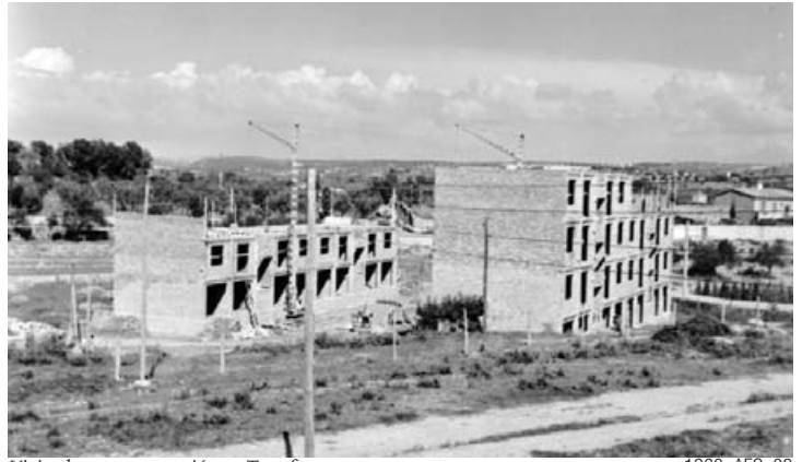
Viviendas en construcción en Torreforta
