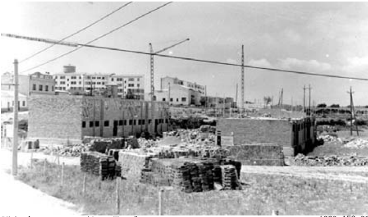
Viviendas en construcción en Torreforta
