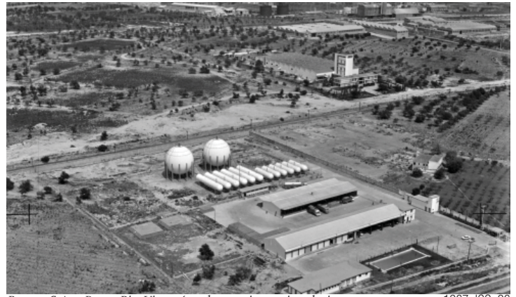
Butano S.A. y Punta Bic. Vista aérea de sus primeras instalaciones
