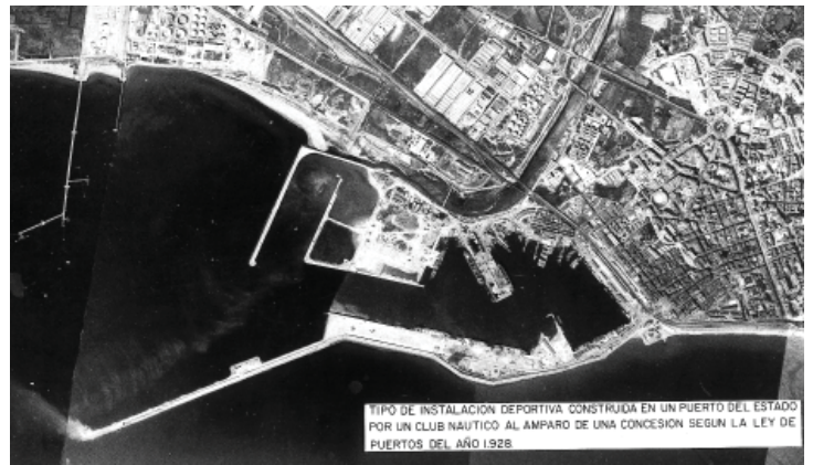
Puerto. Vista aérea de los muelles Aragón, Lérida y Castilla
