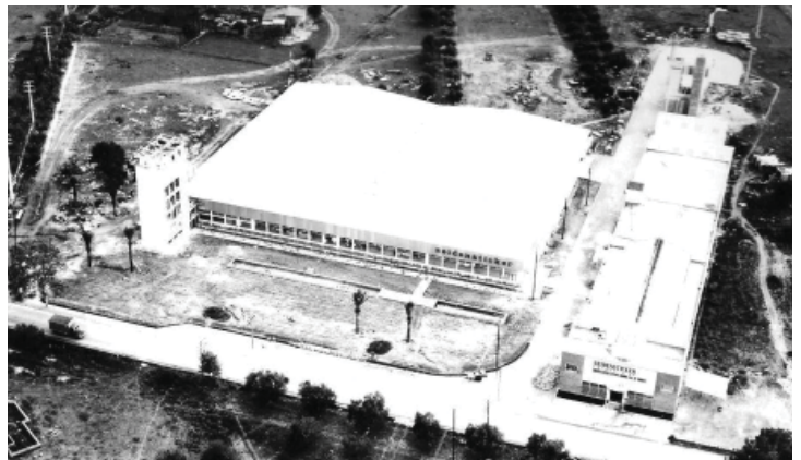
Seidensticker. Vista de la fábrica.
