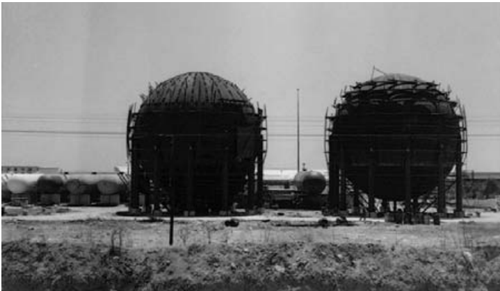
Butano S.A. Construcción de la factoría
