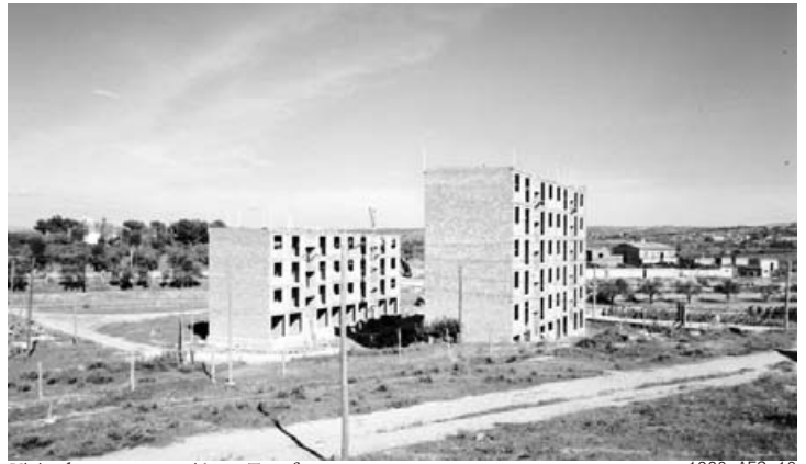
Viviendas en construcción en Torreforta
