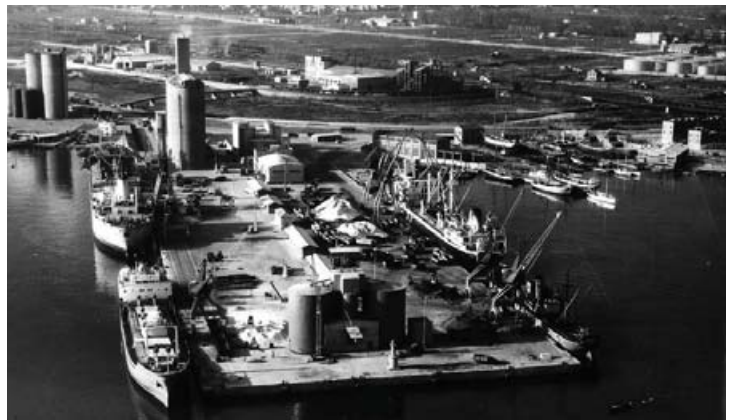
Puerto. Vista del muelle transversal
