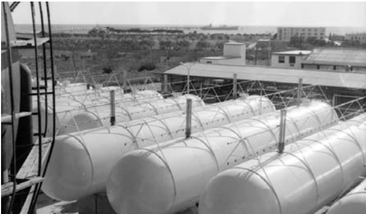
Butano S.A. Construcción de la factoría
