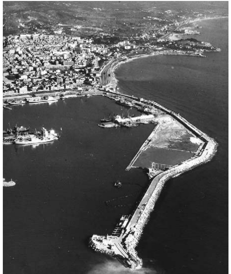
Puerto. Vista aérea de las obras de los diques de Levante y de Aragón
