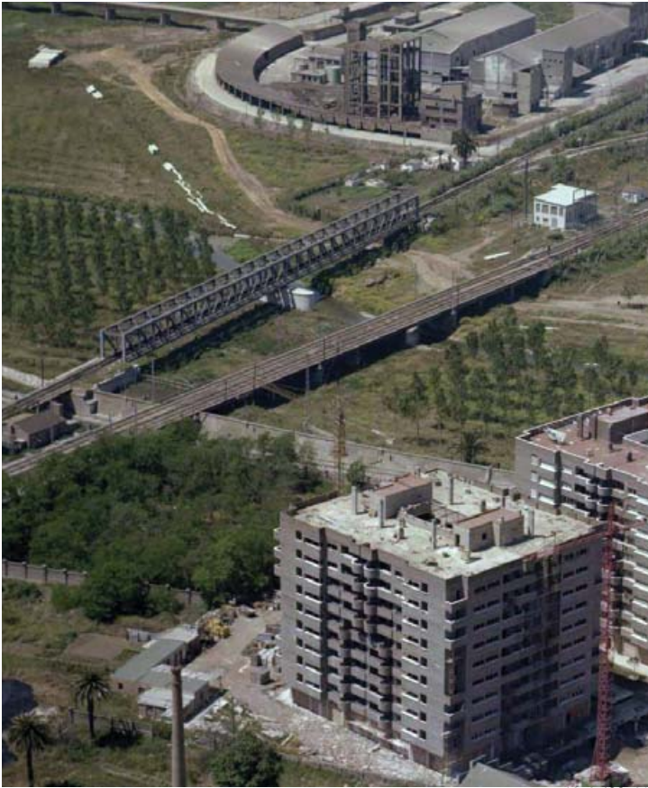
Tarragona. Puentes ferroviarios
