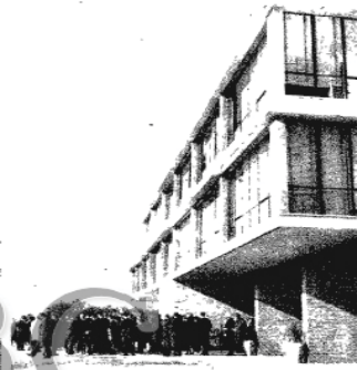
Perspectiva de la fachada de esta nueva fábrica Laforest, S. A., en Tarragona.
