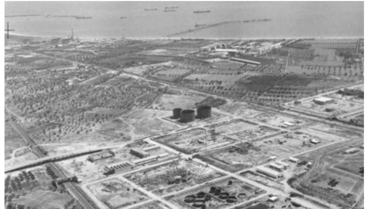
Cepsa. Construcción muelle
