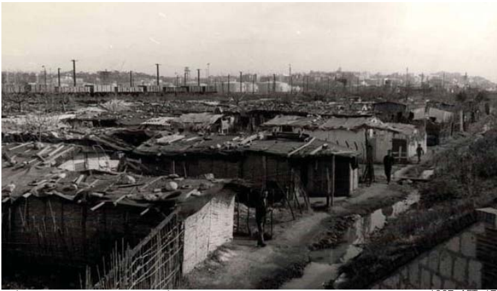
Polígono Entrevías. Barracas en los terrenos
