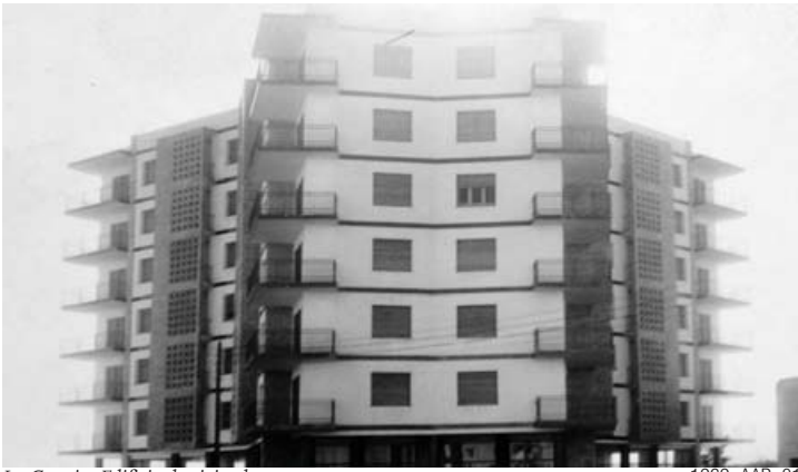
La Granja. Edificio de viviendas
