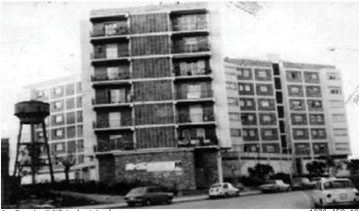
La Granja. Edificio de viviendas
