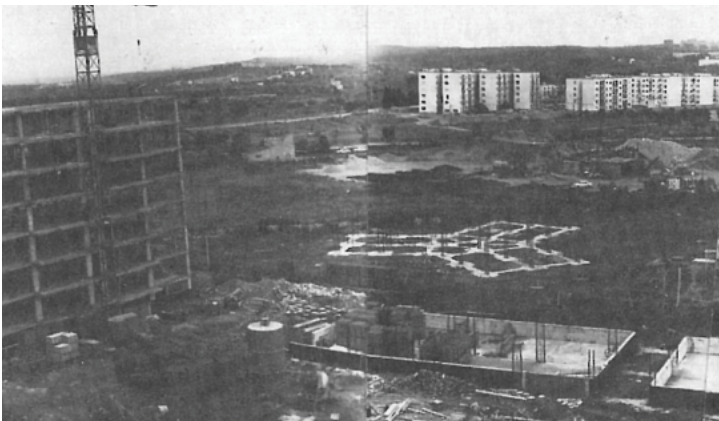
La Granja. Construcción de las viviendas
