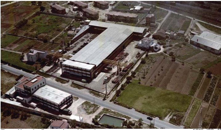
Torrass Herreras Construcciones. Vista aérea
