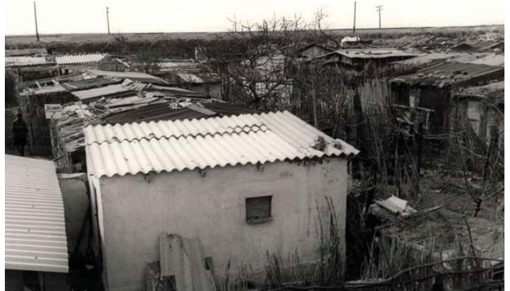
Polígono Entrevías. Barracas en los terrenos
