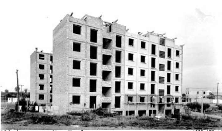
Viviendas en construcción en Torreforta
