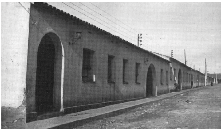
Torreforta. Viviendas Casas Bajas
