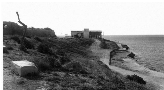
Fig. 127. Restaurante Marina Roc, en ruinas, antes de ser demolido. Fue construido en la antigua cantera de la Punta del Miracle.
