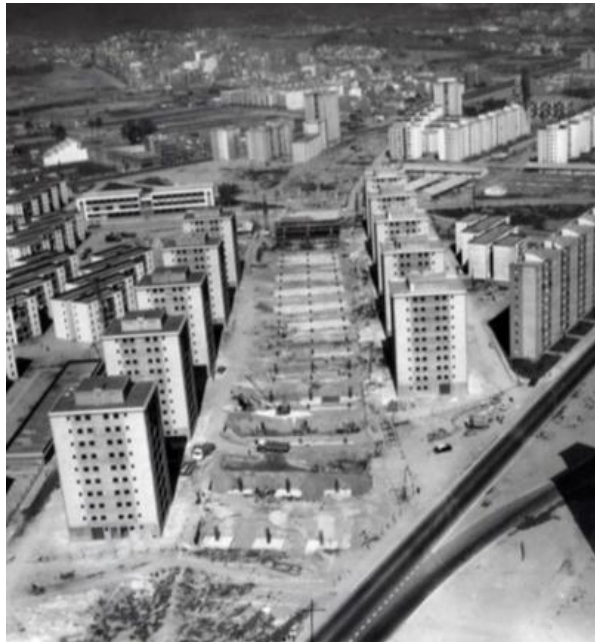
Figura 230: El polígono de la Paz en Badalona, en una imagen a medio construir del viaducto de la autopista de Mataró que atraviesa el barrio. Intervenciones como esta ponen de manifiesto que a menudo se produjo una respuesta combinada entre la construcción de los polígonos de viviendas populares y la de las grandes infraestructuras viarias. Ambas cuestiones, ofrecer vivienda para los niveles de renta obrera en la época y resolver con nueva obra pública el crecimiento exponencial de la movilidad motorizada, centró los afanes de las administraciones públicas de aquellos años. Pero la respuesta a estas cuestiones a menudo fue tan dudosa como lo expresa la distancia miserable entre las ventanas de las viviendas y los fundamentos del viaducto en construcción. Fuente: Parcerisa i Bundó. J. 2013: 39)
