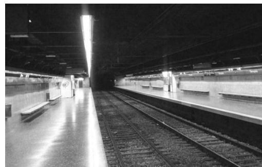
Figura 293: Estación Fondo . Fuente: TMB
