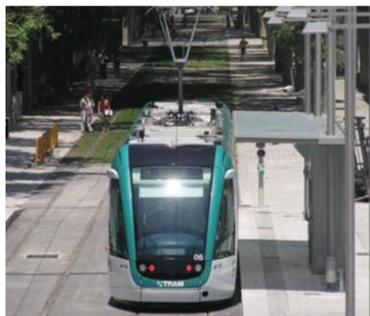
Figura 309: Trambesós, Estación Ciutadella-Villa Olímpica. Fuente: Online disponible en: http://www.trenscat.com/tram/ciutadella_ct.html
