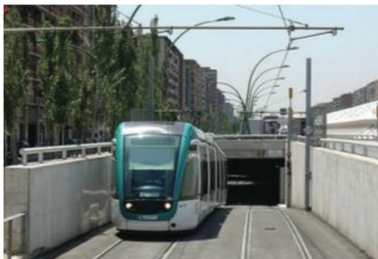
Figura 307: Interior estación Besós y punto de soterramiento (línea T5). Fuente. Online disponible en: http://www.trenscat.com/tram/besos_ct.html
