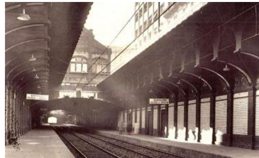
Figura 196: Andenes del apeadero, vista de la fachada posterior del edificio en superficie y tendidos eléctrico. Fuente: http://redferroviariabcn.blogspot.cl/2011/05/el-apeadero-de-passeig-de-gracia-y-el.html
