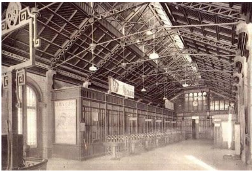
Figura 194: Interior del edificio del apeadero. Fuente: http://redferroviariabcn.blogspot.cl/2011/05/el-apeadero-de-passeig-de-gracia-y-el.html
