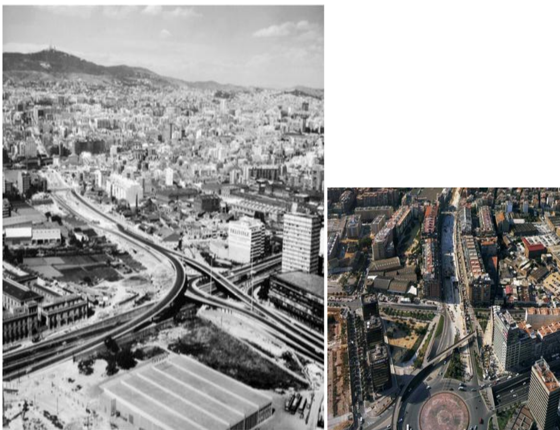
Figura 247: Pasos elevados sobre plaza Cerdà 1970. Su diseño estuvo en función de reducir los cruces del viaducto, la adopción de la idea de múltiples tréboles individualizados que en su conjunto conforma una barrera urbana de segregación. Fuente: Guàrdia i Bassols, M. 2002: 127.
