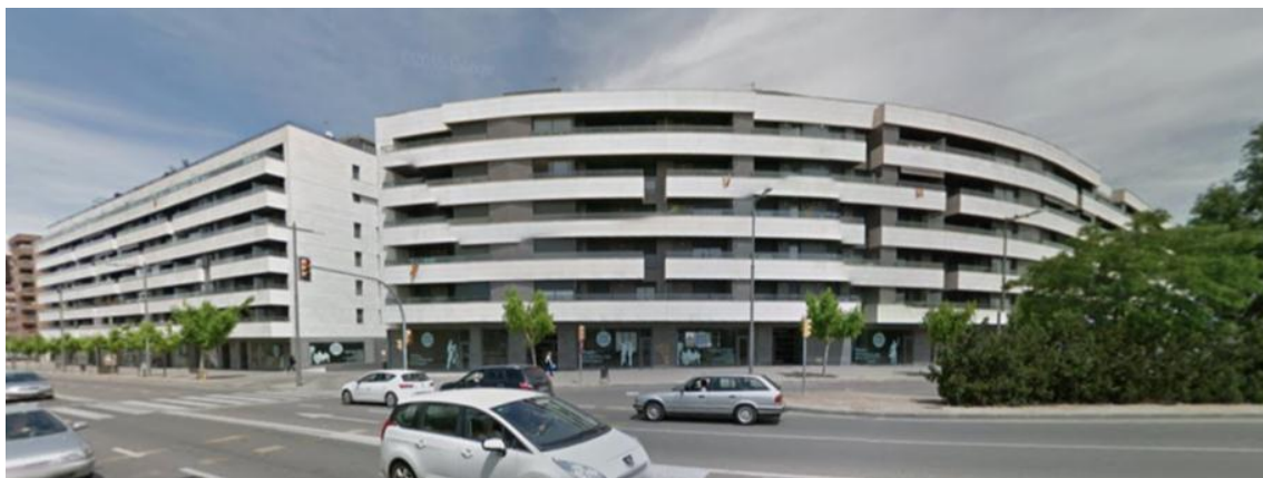
Figura 141: Alineación edificios homogéneos. Intersección Av. Barcelona con Av. de l'Estudi General, Lerida. Fuente archivo personal.
