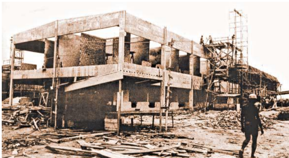
Figura 8.7. Construcción del Campus Universitario Prof. José Aloísio de Campos en 1979
