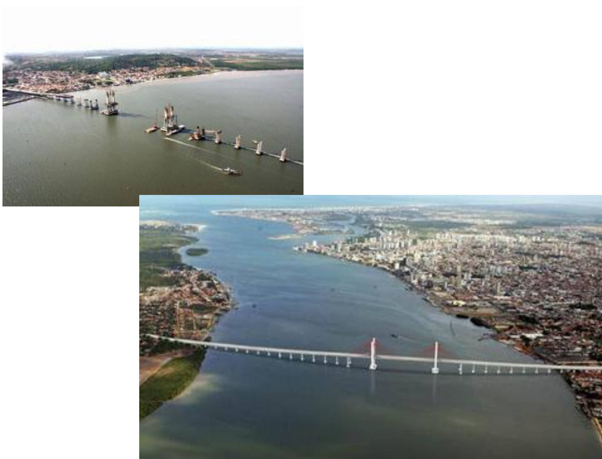
Figura 10. 8. Construcción del puente Constructor João Alves, 2003 y 2006.
