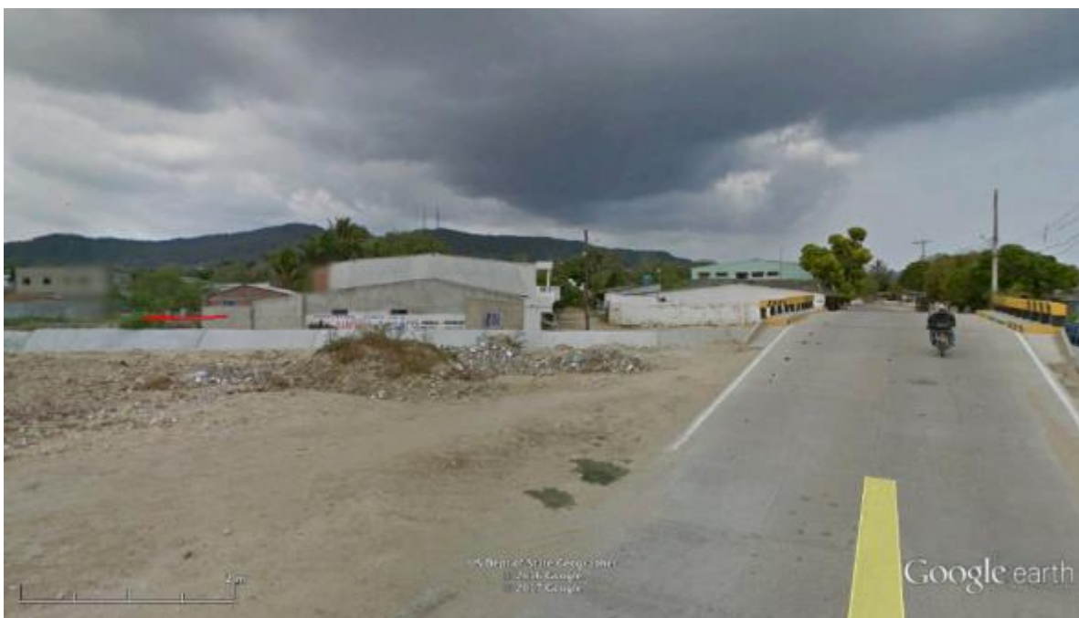
Foto 46: Sector de la pieza centralidad del mar
