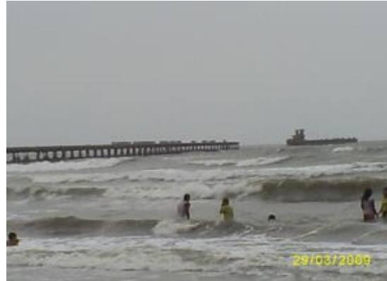
Foto 42: Muelle de Puerto Colombia
