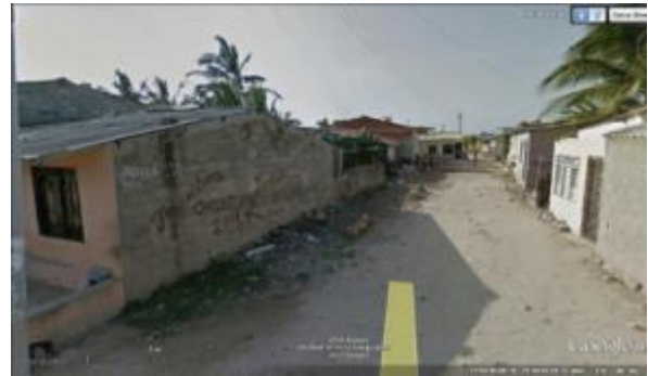
Foto 30: Estado del sector del Barrios Flores y Siape.
