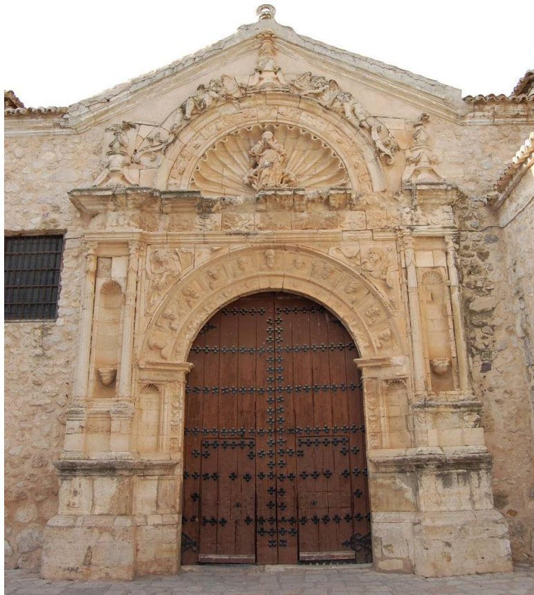
Figura 6.1. Portada principal del siglo XV de la Iglesia de Nuestra Señora de la Asunción de Corral de Almaguer (Toledo) antes de las intervenciones de restauración.
