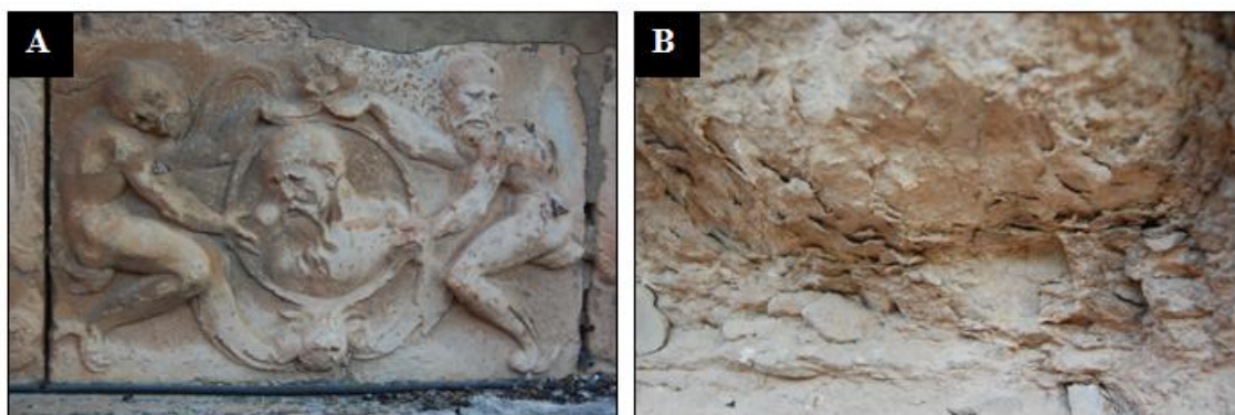
Figura 1.6. A y B) Detalles del friso de la portada principal de la Iglesia de Nuestra Señora de la Asunción de Corral de Almaguer (Toledo), donde se produce la sulfatación del soporte pétreo.
