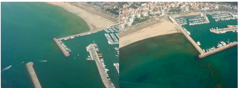
Figura 3. Fotografies aèries de la platja i el port de l'Estartit on es pot observar la discoloració de l'aigua deguda a la presència d' A. taylori i gymnodinoids.
