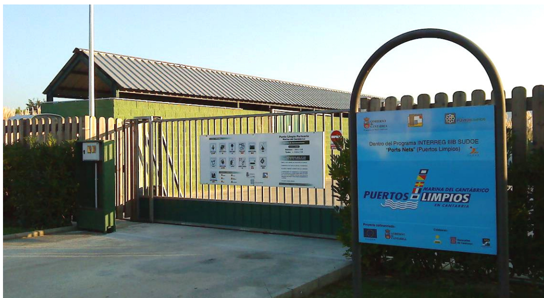
Fotografía 12: Instalación piloto Punto Limpio de Marina de Santander (Camargo). Fuente: Autor.
