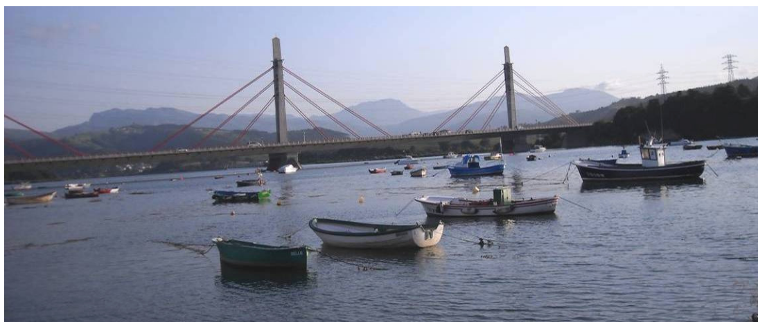
Fotografía 20: Puente de Colindres de la Autovía del Cantábrico. Fuente: Autor.
