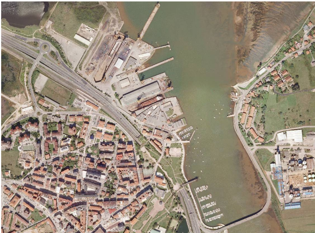
Fotografía 34: Ortofoto de la Ría de Astillero, en el borde inferior se sitúa el puerto deportivo de El Astillero con las dársenas de San José (al Norte) y la de Orconera (al Sur). Fuente: Gobierno de Cantabria.
