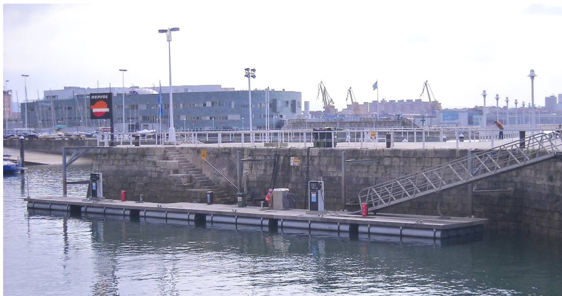
Fotografía 1: Estación de servicio del puerto deportivo de Gijón, gestionado por la Autoridad Portuaria de Gijón. Fuente: Autor.
