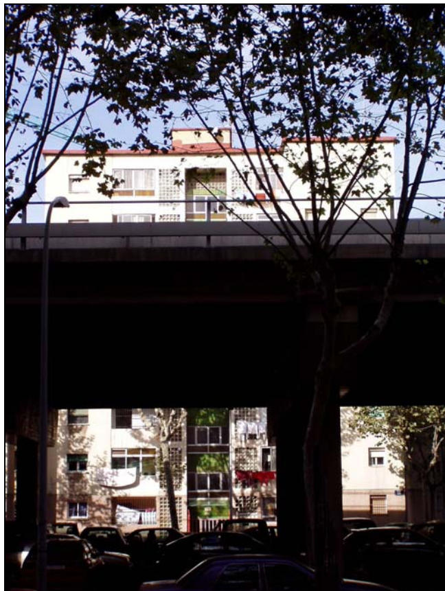
FOTO A2: Autopista que corta el barrio de San Roque
