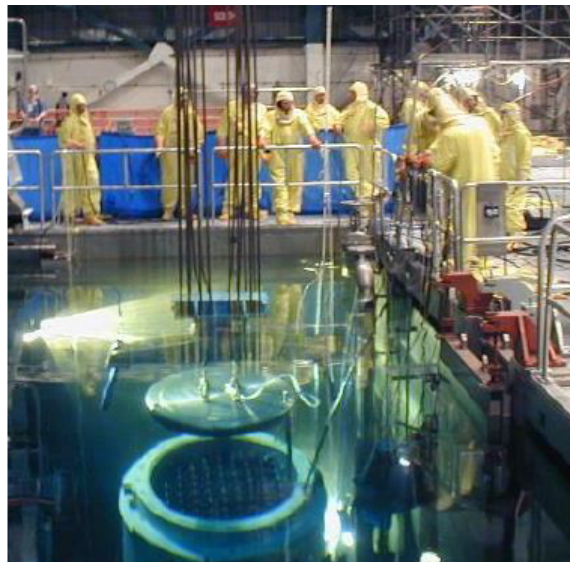
Figura O.5: Ejemplo de descenso de la tapa del MPC. Fuente: [8]
