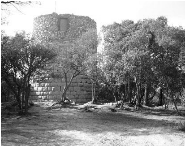
Fig 87. Imatge de la Torrassa del Moro (foto: R. Ballo).
