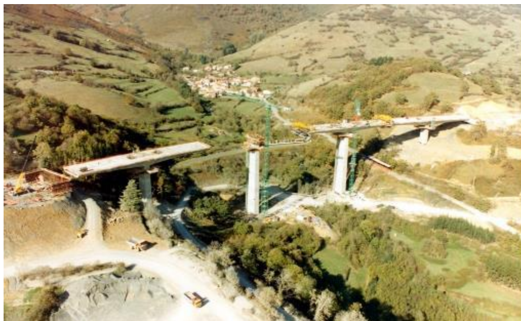
Figura 17. Construcción de la T de la pila 2.
