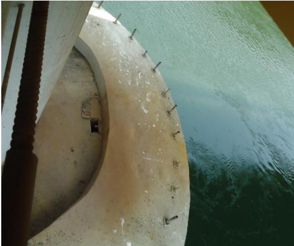
Figura 49. Flujo del río aguas abajo de la pila n°5. Foto tomada por Apia XXI IMC el 17/05/2013.
