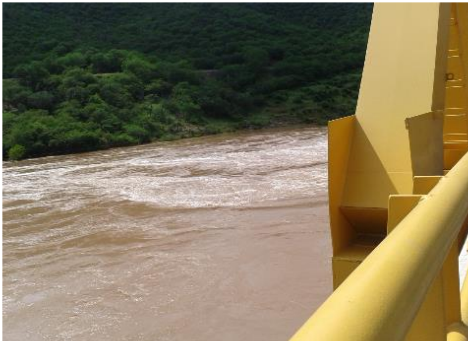
Figura 50. Turbulencias desarrolladas aguas abajo de la pila n°5. Foto tomada por Apia XXI IMC el 21/09/2013.
