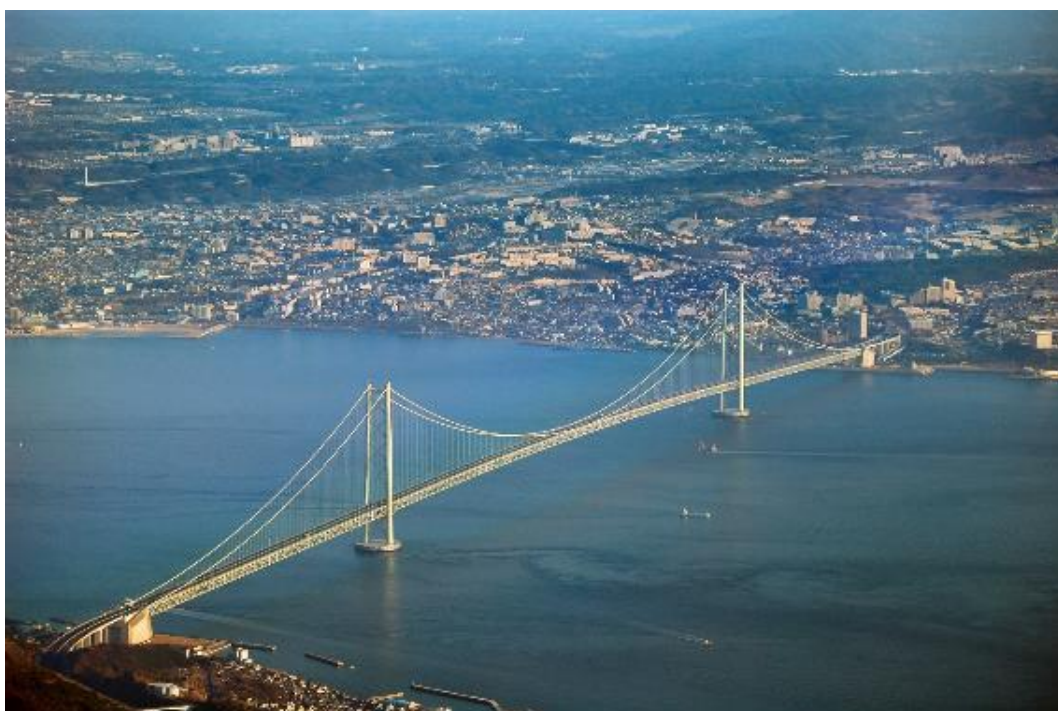
Figura 153. Akashi-Kaikyo (Japón). Puente metálico colgante de 3911 m con vano central de 1991 m y vanos laterales de 960 m.
