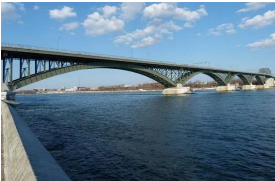
Figura 148. Viaducto de Peace (Canada, 1927). Combinación de arcos inferiores y un vano tipo arco superior de sección metálica. Longitud total de 1768 m.
