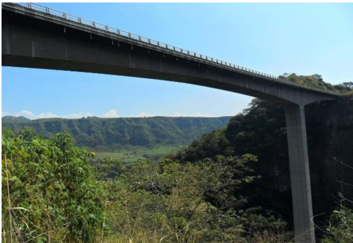
Figura 81. Aspecto del vano central y pila 4 del Puente Beltrán. Foto tomada por Apia XXI IMC.
