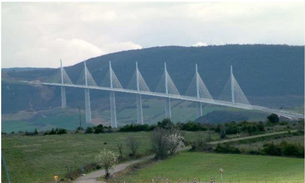
Figura 151. Millau Viaduct (Francia). Puente de vanos atirantados de 342 m de longitud máxima y sección de tablero tipo cajón metálico.
