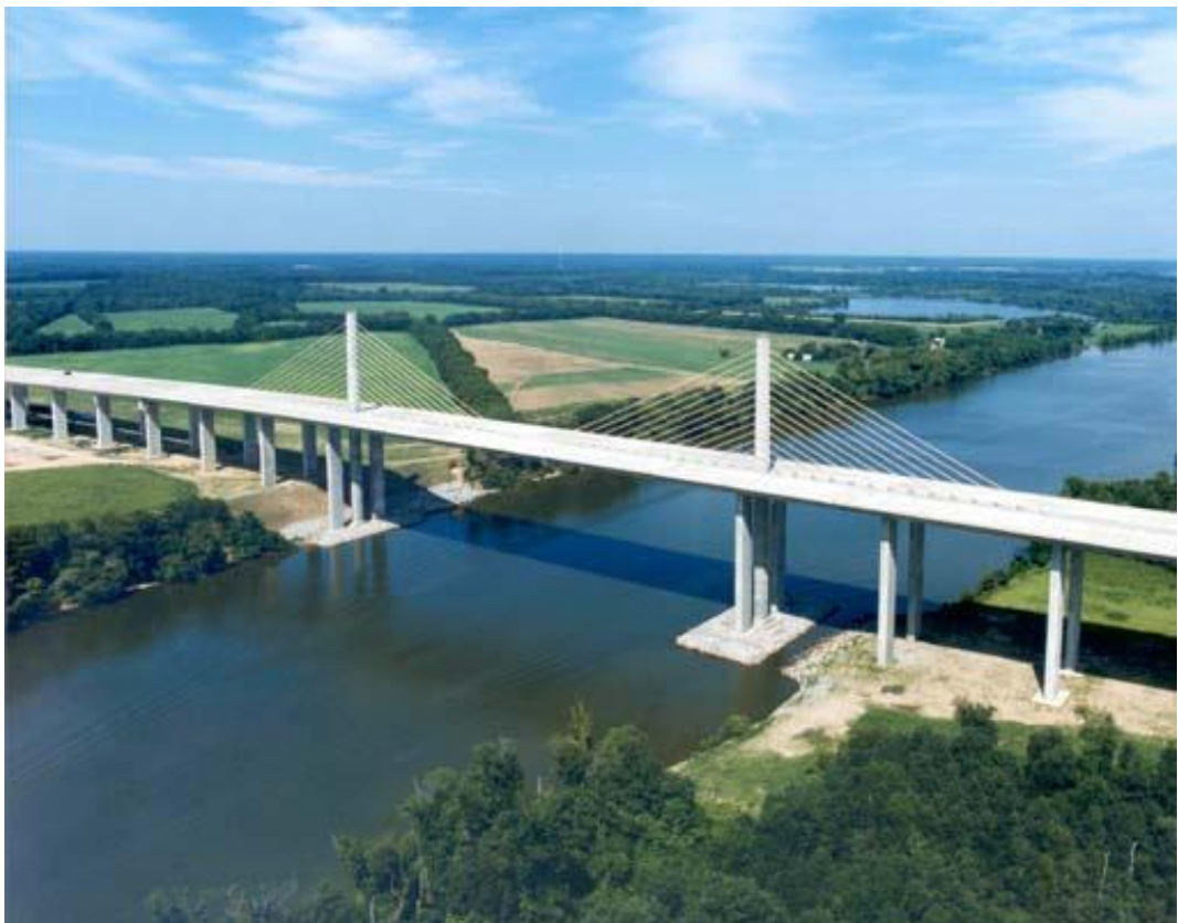
Figura 155. Varina-Enon Bridge (EE.UU). Puente atirantado con tablero tipo cajón y 192 m de longitud de vano central.
