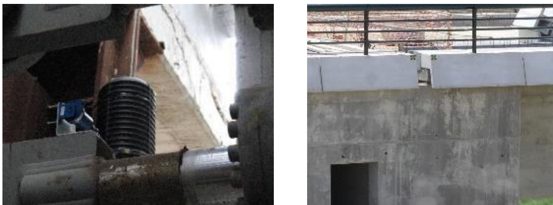
Figura 6. Medida del movimiento relativo tablero-estribo. (APIA XXI, S.A.)
