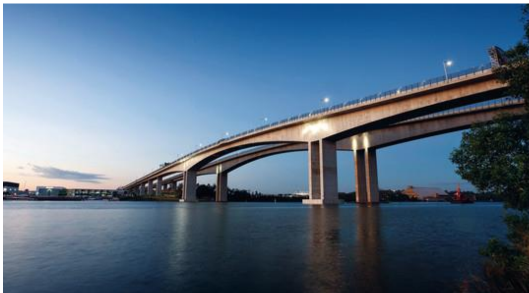
Figura 146. Gateway Bridge (Australia). Vano principal de 260 m.
