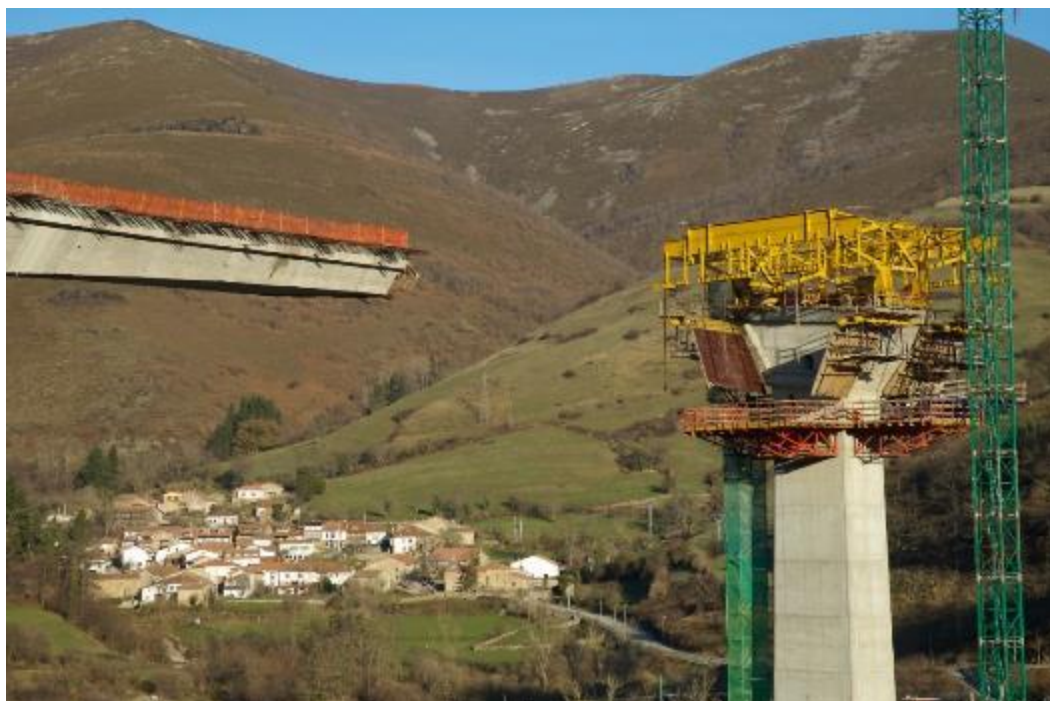
Figura 16. Montaje de carros de avance sobre dovela 0.
