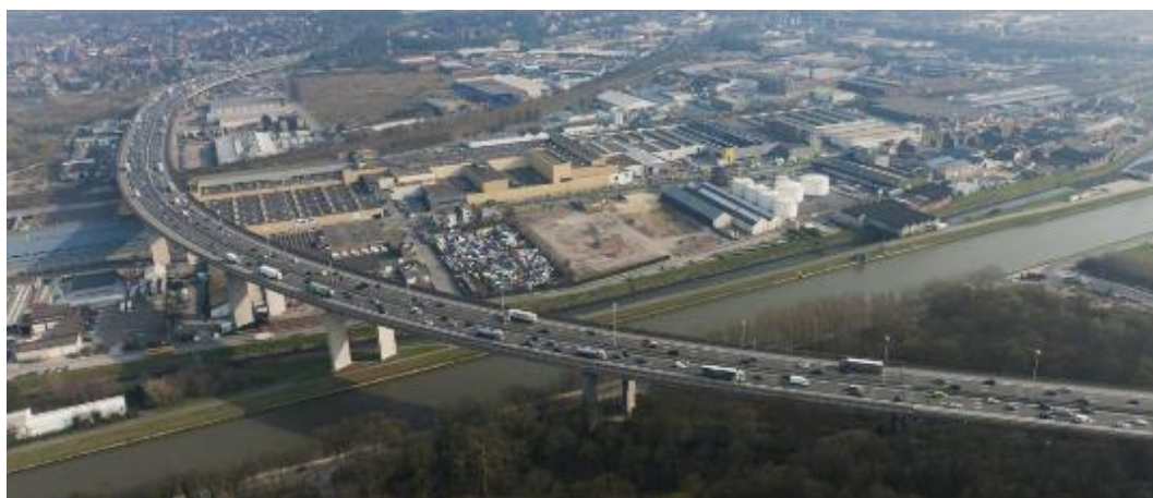
Figura 147. Viaducto de Vilvoorde (Bélgica). Vano principal de 160 m.
