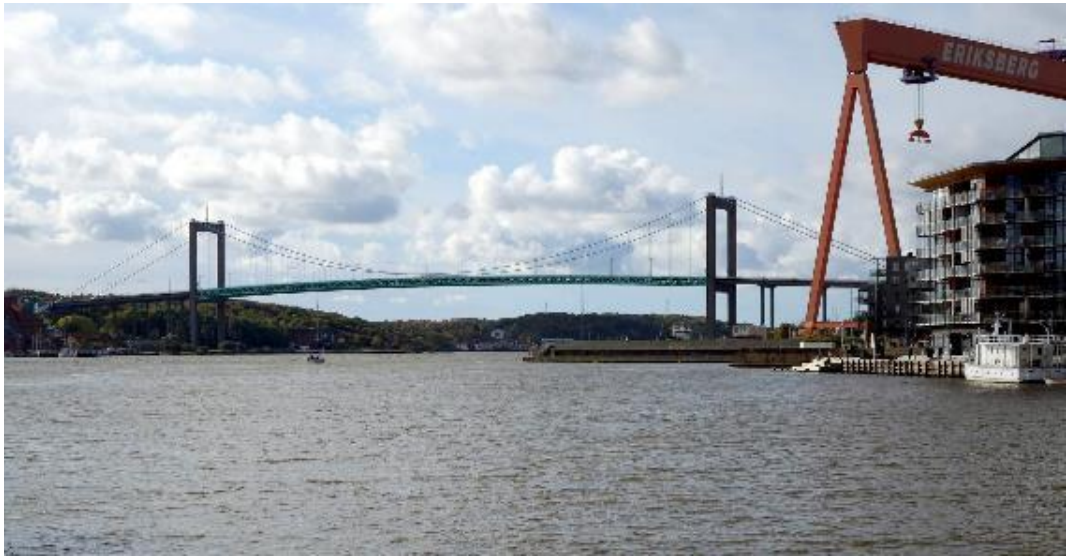
Figura 154. Alvsborg Bron Bridge (Suecia). Puente colgante con vano principal de 417 m y tablero de sección celosía metálica. Construido en 1966.
