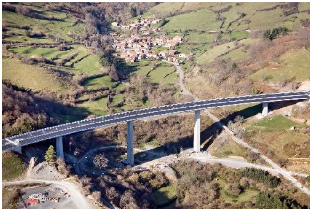
Figura 14. Vista aérea del viaducto, con el pueblo de Pujayo al fondo.
