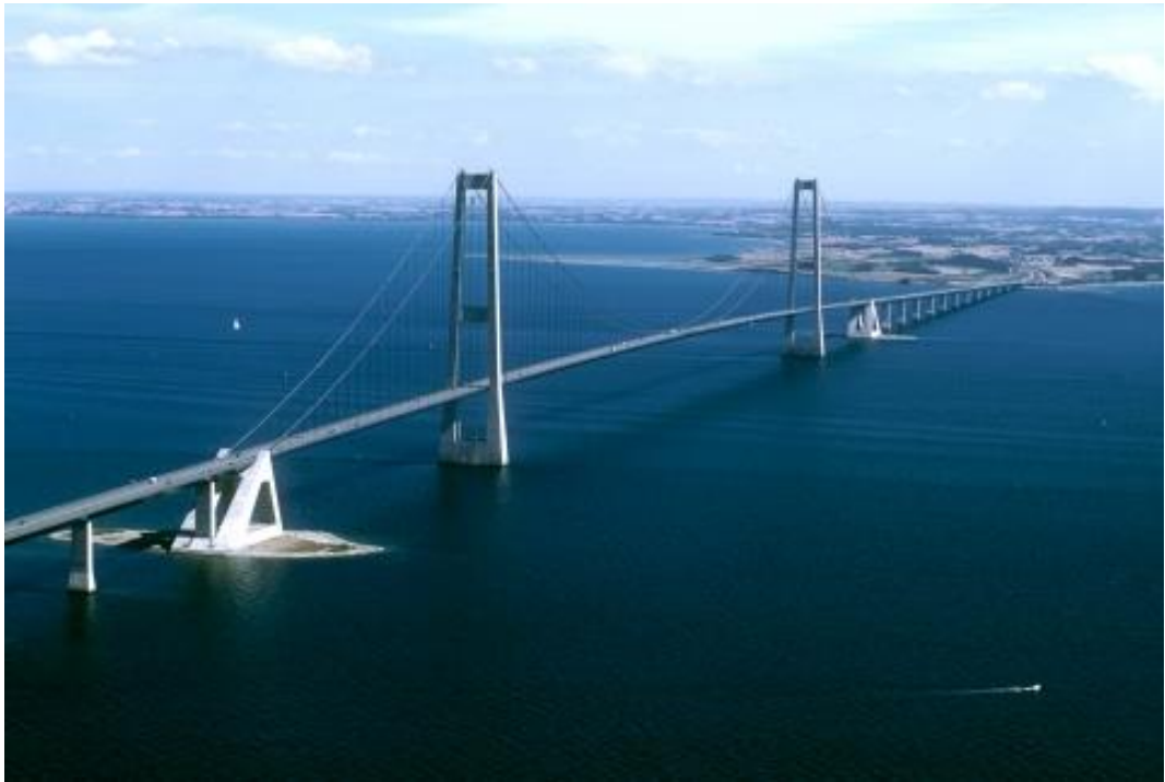
Figura 150. Great Belt East Bridge (Dinamarca). Vano colgante principal de 1624 m y sección de tablero tipo cajón metálico.
