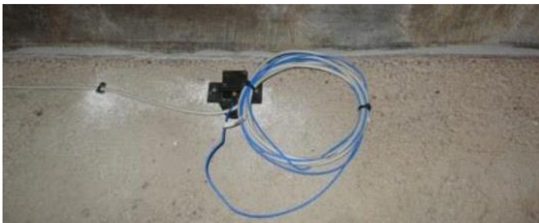
Figura 4. Acelerómetro en losa inferior de tablero. Viaducto Arroyo Las Piedras (LAV Córdoba-Málaga).
