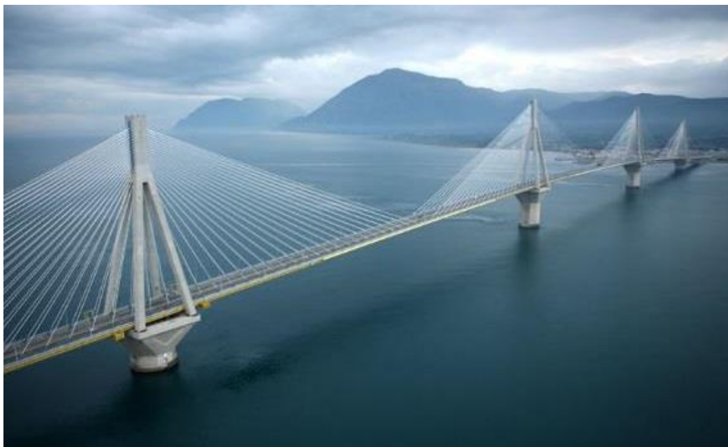
Figura 152. Harilaos-Trikoupias (Grecia). El puente principal tiene cinco vanos atirantados de 560 m de longitud máxima.
