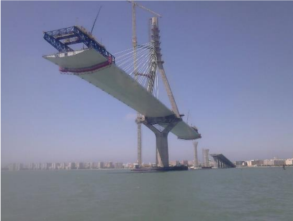
Figura 20. Construcción mediante avance en voladizo sobre Pila 12. Junio 2014.
