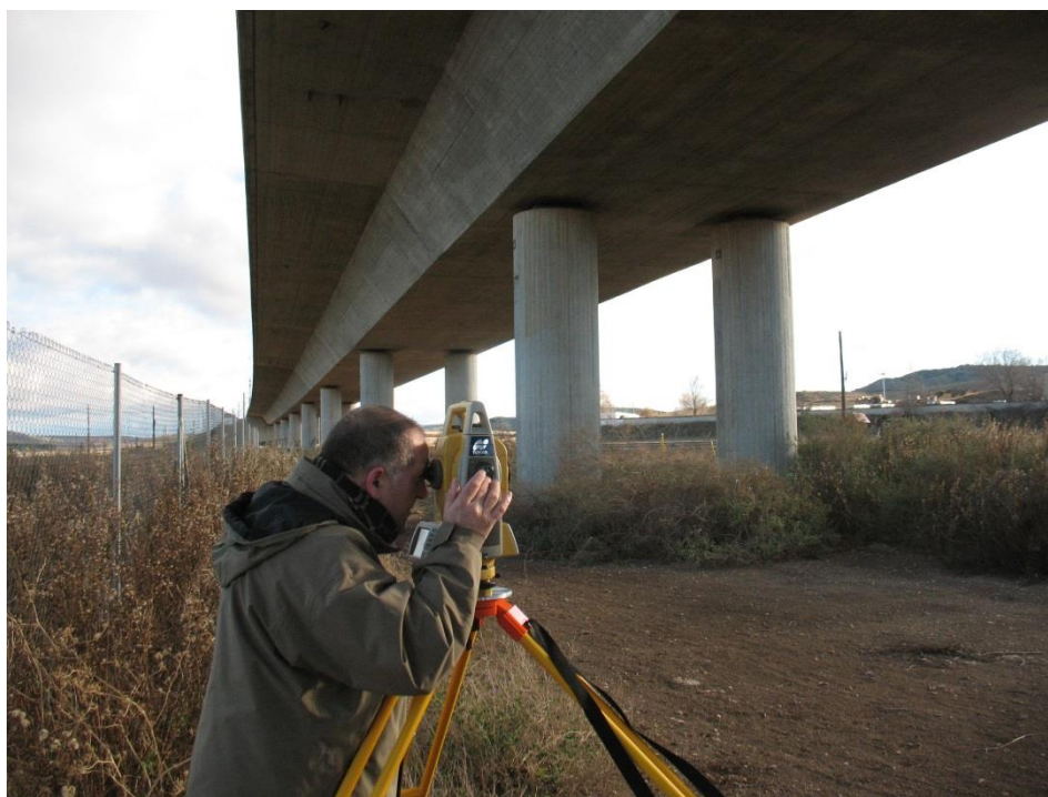
Figura 36. Control de la verticalidad de las pilas mediante topografía en Viaducto de Anchuelo I (LAV Madrid-Zaragoza).
