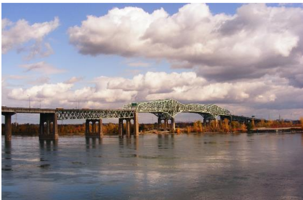
Figura 149. Puente de Champlain (Canada, 1962). Vanos principales metálicos tipo cantilever. Longitud total de 7412 m.
