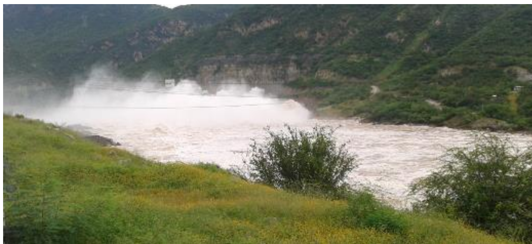
Figura 47. Aspecto del cauce aguas arriba del puente. Foto tomada por Apia XXI IMC el 21/09/2013.
