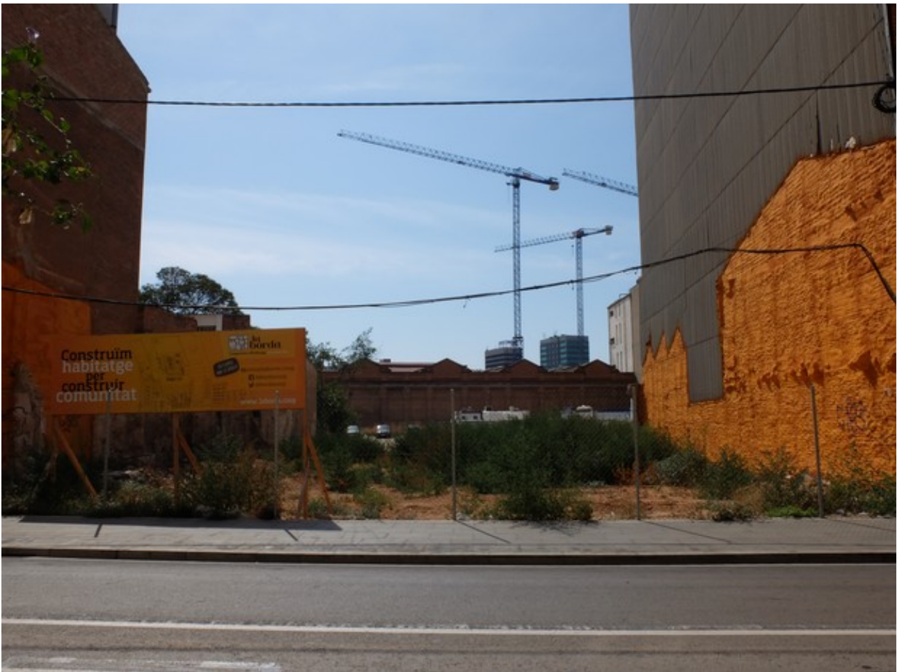
Fig. 6.23 Solar y cartel de obra con Can Batlló al fondo (verano 2016). Fuente: CCM
