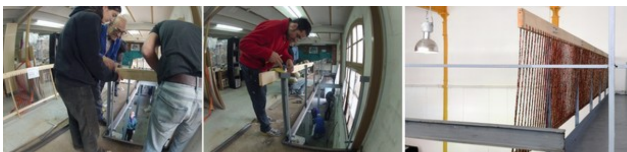
Fig. 6.15 Construcción de la barandilla con cuerdas, maderas y perfiles metálicos. Fuente: LaCol
