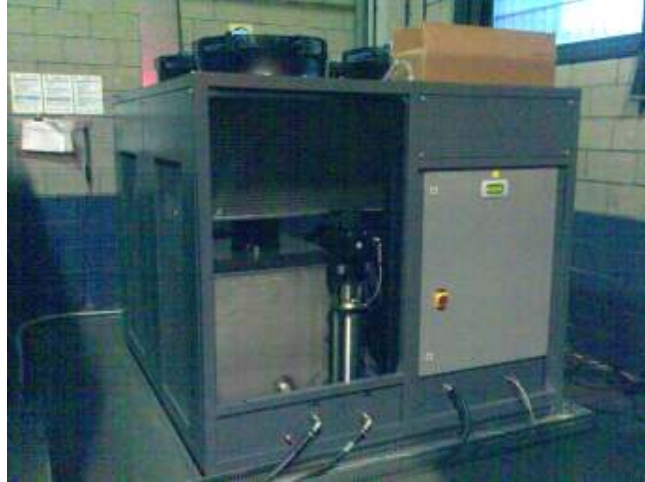
Fig.3.6: Sistemas de refrigeración directa "Chiller".
