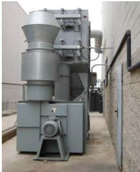
Fig.3.9: Sistema externo de extracción y filtrado de partículas y gases.
