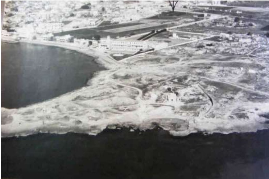
Fig. VI.15. Vista aérea de Cala Gamba y el Sanatorio de San Juan de Dios
