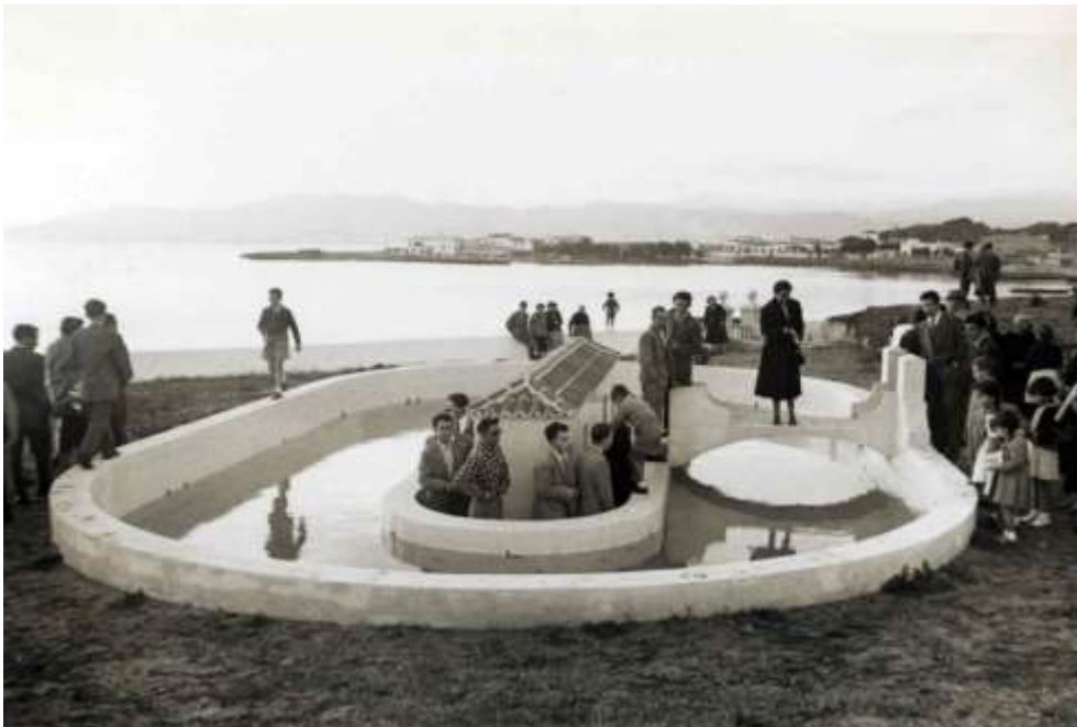
Imagen superior: entrada por la fachada norte al sanatorio. Imagen inferior: la piscina con el vestuario central y el puente en construcción en 1955. Al fondo, la Punta des Carregador y el Club Nàutic Cala Gamba. Fuente: gentileza de P. Galiana Veiret
