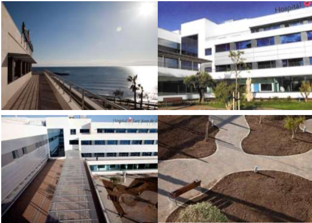
Fig. XII. 11. Aspectos de la remodelación del edificio antiguo del HSJD en 2014
