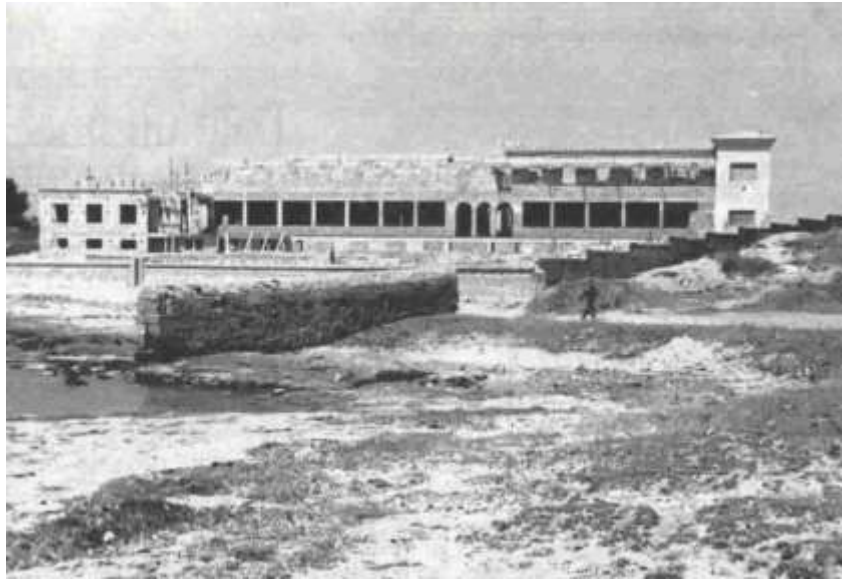
Fig. III.3 El Sanatorio infantil de San Juan de Dios en construcción. Años 1953 o 1954
