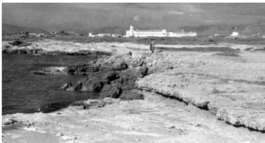
Estado de la construcción prácticamente acabado. Fuente: archivo fotográfico de P. Galiana Veiret
