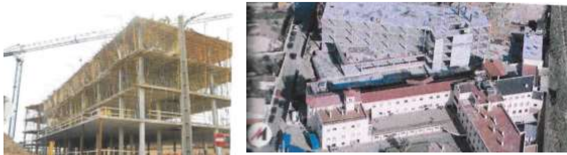
Fig. XI. 4. Imágenes de la construcción del nuevo edificio del HSJD en 2005
