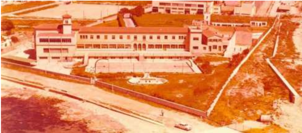
Fig. VI.18. Vista de la fachada marítima y panorámica del Sanatorio infantil de San Juan de Dios
