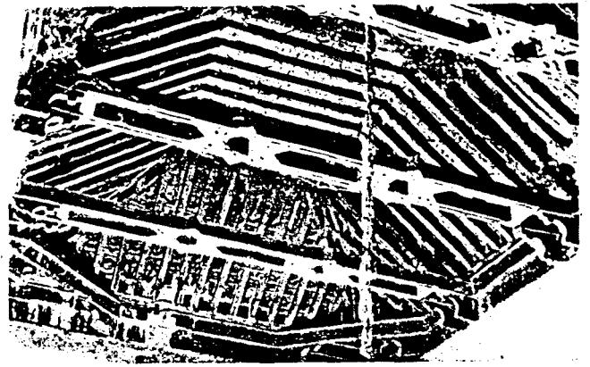
2. A les cobertes, per tal d'evitar o reduir la flexió, es fan sostres amb diverses solucions d'armadures, com per exemple aquesta de la Casa Fernández de Córdova de Granada, en les quals els cavells estan alirantals en els dos terços de la seva altura per les entrecruces que suporten la sinca o pany horitzontal.
