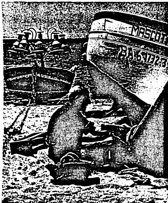
14 El recurs dels productes estètics per a aconseguir la estanquitat és tradicional a tot arreu on hi ha mar, però la tasca del calafateador exigeix molt de manteniment perquè dura poc en condicions variables d'humitat i temperatura.
