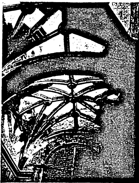
9 El paper portant dels nervis de la tracera gòtica, com a elements diferenciats de la massa envoltant, es fa evident en aquesta ruïnosa ermida de Tormentosa (Logroño).
