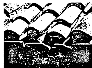
7 La teula aràbiga té una sofisticada geometria tronco-cònica que li permet de garantir el cavalcament, no només en el sentit del pendent sinó també en el que li és perpendicular i les peces s'espigalitzen alternativament en carenes cobertes. El repertori de teules especials va arribar a ésser amplíssim. Una de les més comunes és la tortuga o tortugada, com aquesta del Convent dels Angels.
