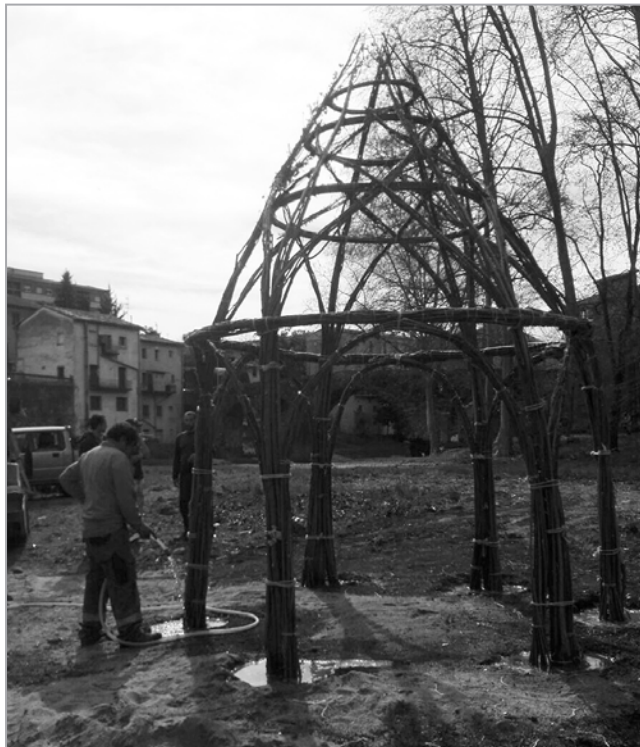
Imagen 3. Proceso de construcción de una estructura de plantas vivas con técnicas de cestería de Ona Trepata en Sant Joan les Fonts, Girona (febrero de 2017)
