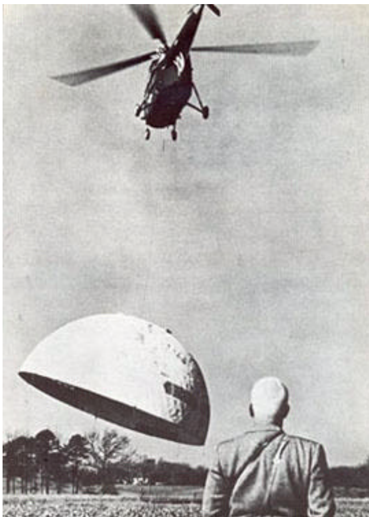
1. A casa voadora: Fuller presenciando o transporte aéreo de um de seus domos, 1954.
