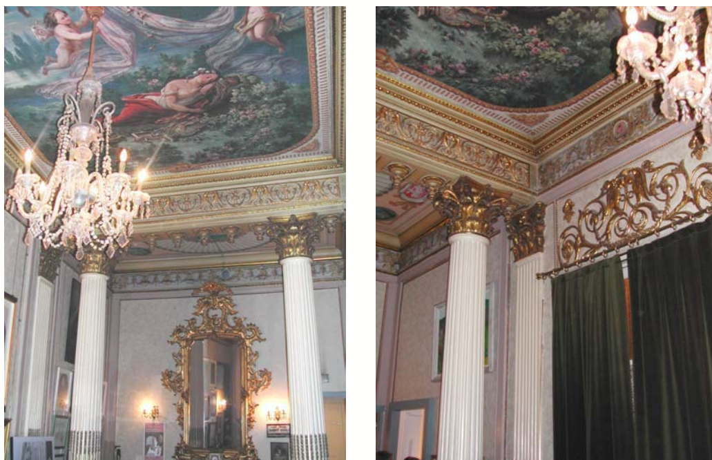
Fig. 56 i 57. Dues imatges de la sala amb alcova. les columnes separen ambdós espais. Els paraments de la sala no tenen pilastres en lloc seu trobem emmarcaments fets amb plafons i motlures.
