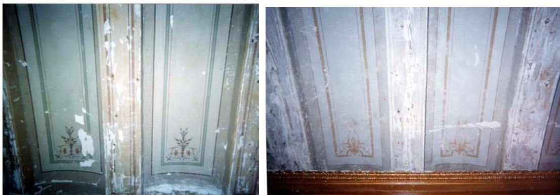
Fig. 174 i 175. Sostres de la Casa Juncadella, 1853.
