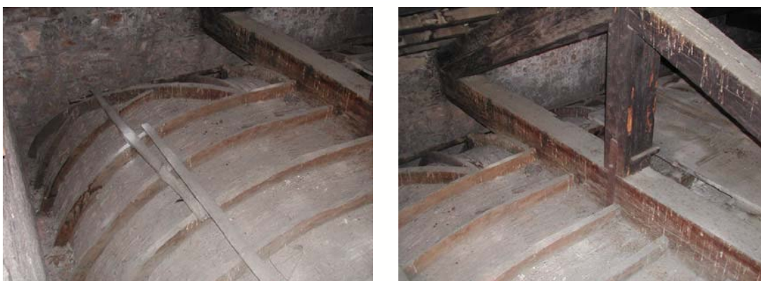
Fig. 79 i 80. Estructura de l'escòcia del saló del Palau Moja.
