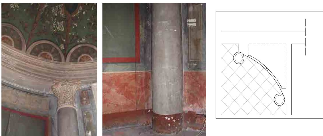
Fig. 46, 47 i 48. Com es pot veure en les imatges la forma arrodonida dels paraments s'obté amb els envans de fusta. Les columnes i la cúpula s'insereixen en un espai quadrat i sostres pla.
