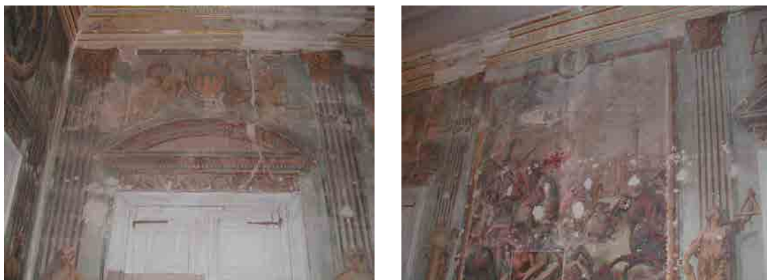
Fig. 19 i 20. Detalls del costat llarg del saló.
