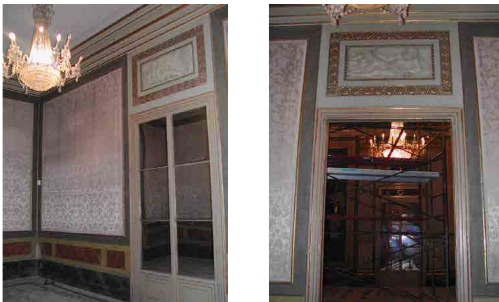
Fig. 32 i 33. Detalls de l'estrada.
