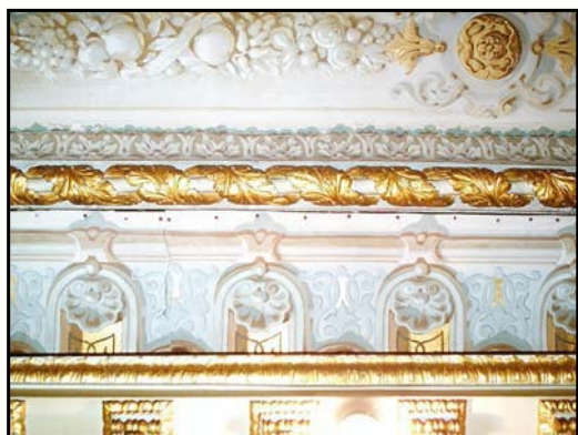
Fig. 54. En aquesta imatge s'aprecien els claus que fixa la tela pintada de l'escòcia
