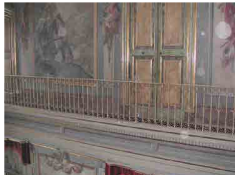
Fig. 8. Detall del passadís que encercla la sala a l'alçada del pis superior
