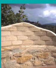
Bloque macizo comprimido por hiperpresión en prensa hidráulica entre 50Kp/cm2 a 100Kp/cm2.
