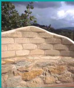
Bloque macizo comprimido por hiperpresión en prensa hidráulica entre 50Kp/cm<sup>2</sup> a 100Kp/cm<sup>2</sup>.
