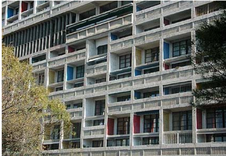
Fig. 1.56. Unité d'habitation, Marsella. Le Corbusier
