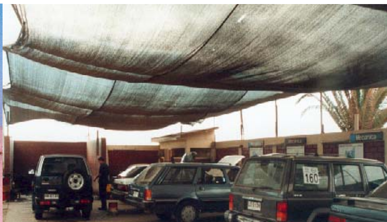
Fig. Nº23 CUBIERTA DE TALLER DE AUTOMÓVILES, ANTOFAGASTA En toda su informalidad, la solución de esta cubierta es apropiada para las necesidades de sombra y retiene la humedad y la contaminación del ambiente.
