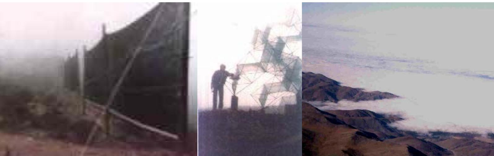
Fig. N° 69 PROTOTIPOS DE CAPTADORES DE CAMANCHACA O ATRAPANIEBLAS INSTALADOS EN LAS ZONAS COSTERAS DEL NORTE DE CHILE / IMAGEN ÁEREA DE LA CAMANCHACA EN EL BORDE LITORAL
