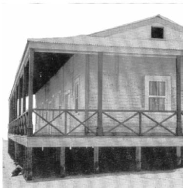
Fig. N°162. Casa con corredor y cubierta ventilada Mejillones, Chile.
