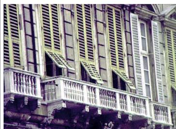
Fig. Nº 193 Protección móvil / edificio en Génova.
