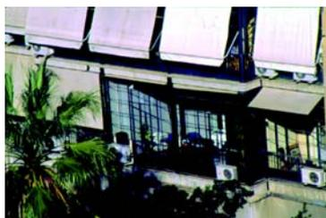
Fig. Nº 187 Protección móvil exterior.
