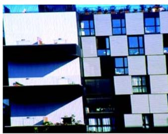
Fig. Nº 190 Protección móvil exterior.
