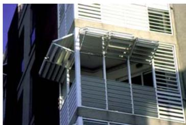
Fig. N°146 Protección solar en edificio de la Barceloneta.
