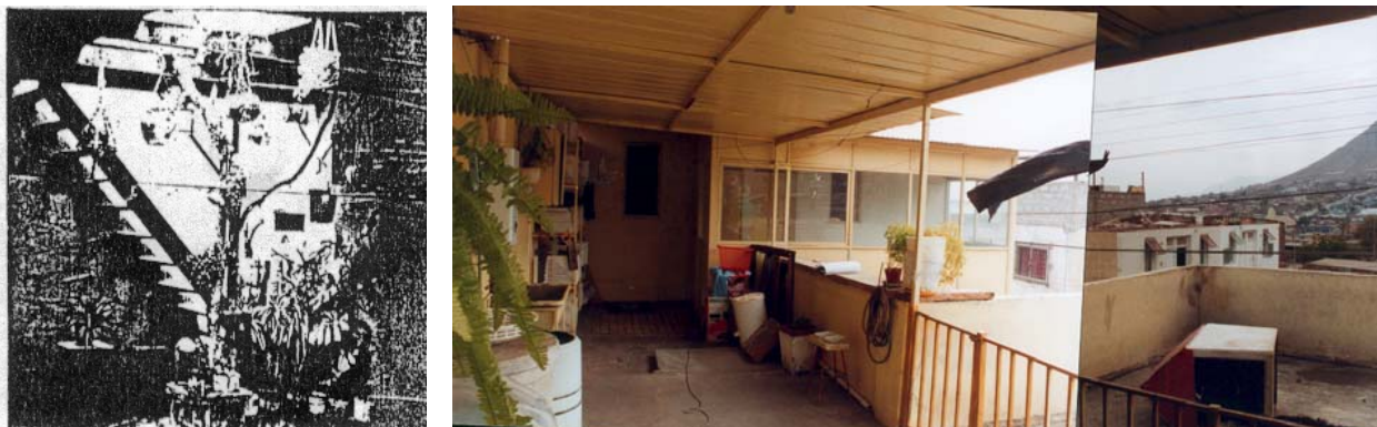
Fig.N° 301(b) El lugar de la escalera, en la mayoría de los casos queda definido un pozo de luz, una gran abertura que se configura como galería, lucernario o ventanal. El caso que se ilustra, con una orientación nor-orienta corresponde a la mejor disposición ambiental de una vivienda, ésta queda protegida del viento SW y del sol poniente, y favorecida con iluminación y radiación norte. Fotos: J. Guerra.
