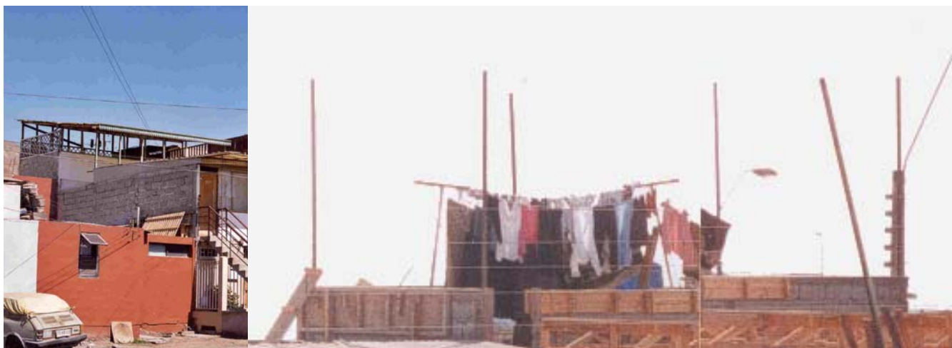
Fig N° 317 HABITAR LA EXTERIORIDAD, OCUPACION DE LA CUBIERTA, ESPACIO DE DOMINIO DEL PAISAJE, RECONOCIMIENTO DE LA DIMENSIÓN DEL TERRITORIO.
