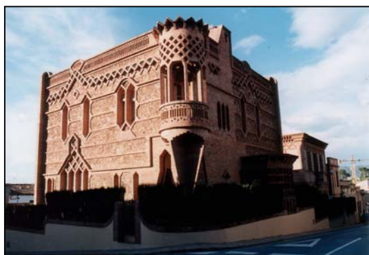
Foto 68. Casa aislada del encargado de la fábrica en la Colonia Güell. Arq. Joan Rubió Bellver. 1900. Fuente: K. Simancas
