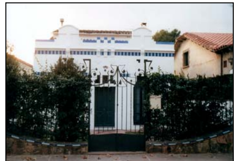
Foto 63. Casa de verano de principios del s. XX. La Garriga. Paseo, Nº 96. Fuente: K. Simancas
