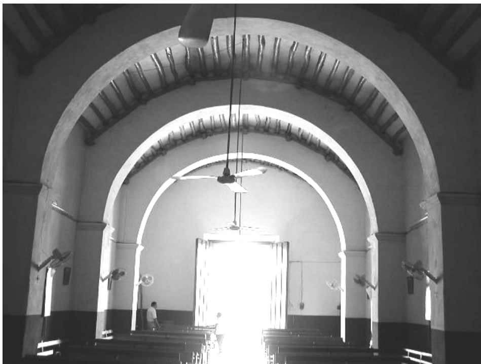
Vista del acceso
