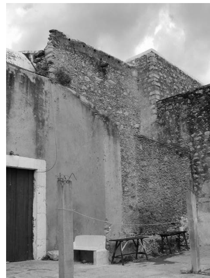
Detalle de unión de la nave a las originales estructuras
