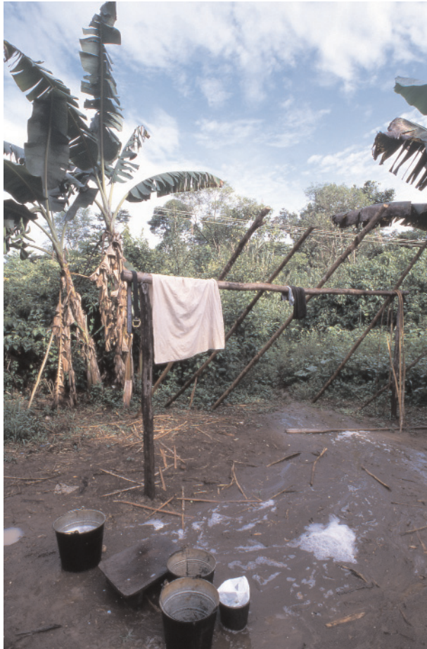
Imagen 97: Vivienda en construcción de la casa 9, 2003. Fotógrafo J. Piqué.
