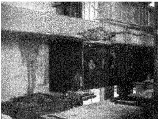
Fig. 3.27 Viga con láminas CFRP con anclaje en sus extremos impidiendo el desprendimiento del laminado, permitiendo desarrollar esfuerzos mayores en el hormigón.
