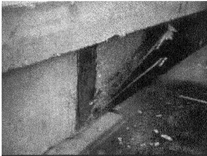
Fig. 3.26 Viga con láminas CFRP sin anclar en sus
