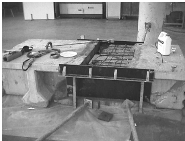
Figura 3.14. Reparación de la junta de dovelas VD-CFK1.
