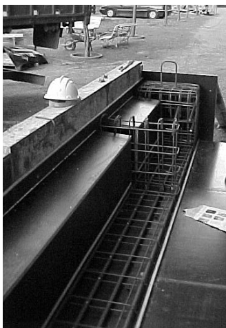
Figura 4.32. Detalle del armado de las vigas V1-SFRC
