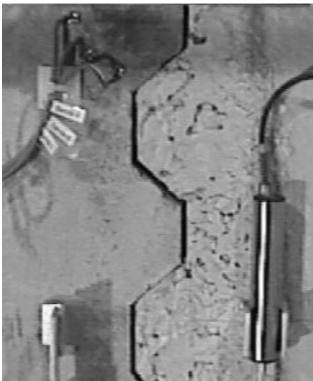
Figura 4.18. PC-C-1. Detalle de la junta instrumentada donde se aprecia la separación entre las llaves.
