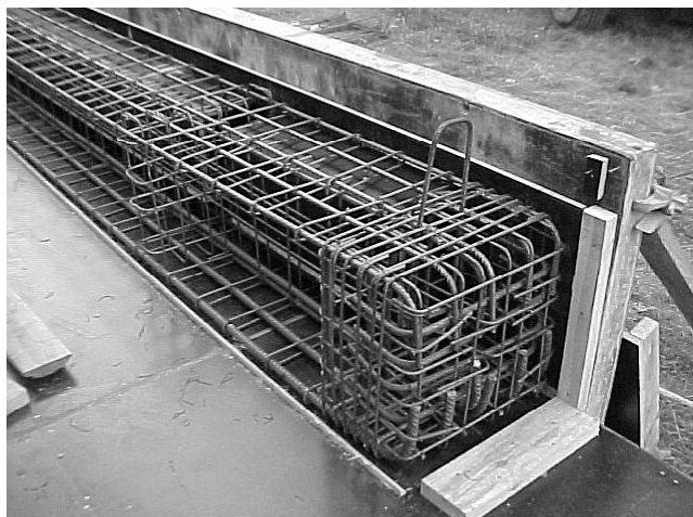
Figura 4.33. Detalle del armado de las vigas V3
