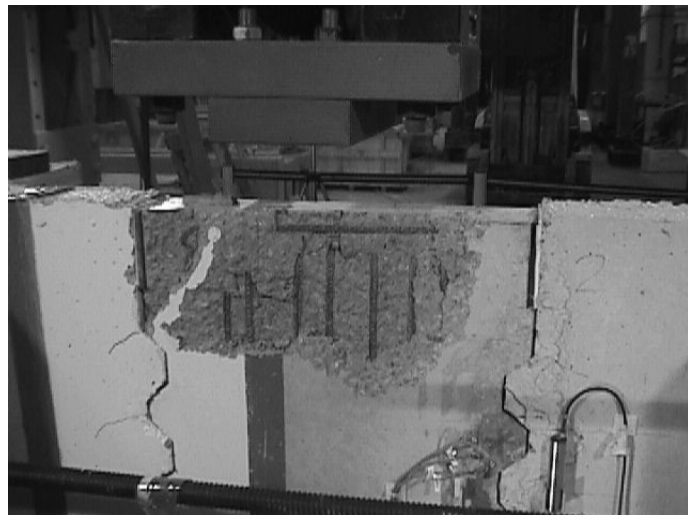
Figura 4.19. Estado en que quedó el punto de aplicación de la carga al finalizar PC-C-1.
