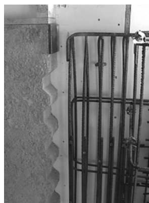
Figura 4.6. Obtención de las juntas con sus llaves conjugadas.
