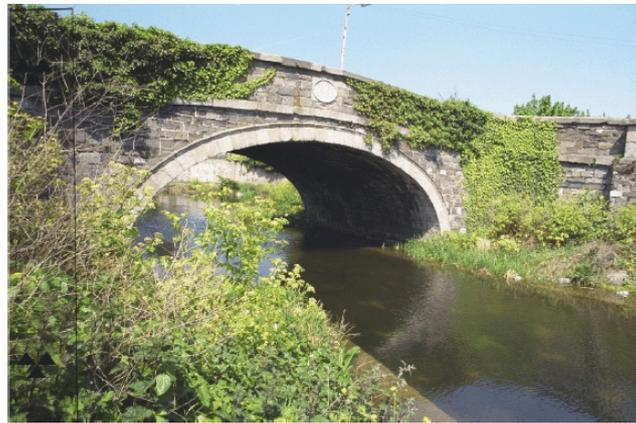
**Figura 1.2** Puente arco típico en obra de fábrica, Griffith Bridge, Dublin (Irlanda)
