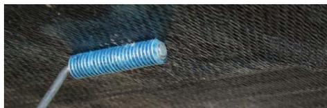
Figura 4.16. Aplicación de la resina epoxi y el tejido de fibra de carbono.
