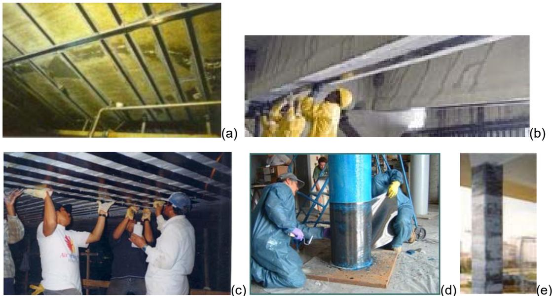
Figura 2.1. Refuerzo de estructuras de hormigón armado con FRP. (a), (b) y (c) Refuerzos a flexión de losas y viga con FRP; (d) y (e) Confinamiento de pilares con FRP (Fib Bulletin 14 2001, BASF)
