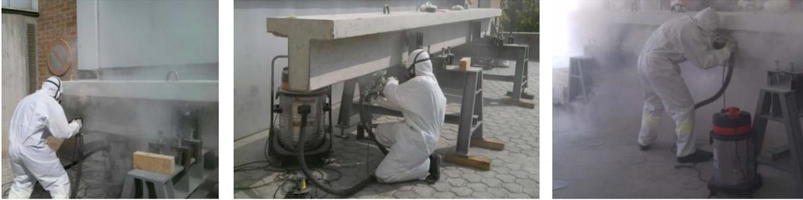
Figura 4.15. Retirada lechada de cemento mediante pulido
