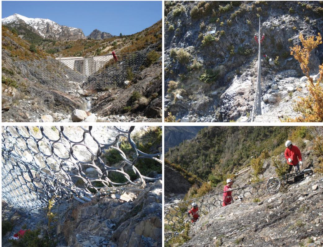
Figura 3.26: Imágenes de algunos detalles del Sistema VX durante la instalación. Vista general desde aguas abajo, vista lateral desde margen izquierdo, detalle de la fijación de los cables intermedios a la roca por medio de los anclajes GA7001, y por último fijación del cable perimetral superior con frenos a los anclajes GA7001. (Fuente: Geobru gg).
