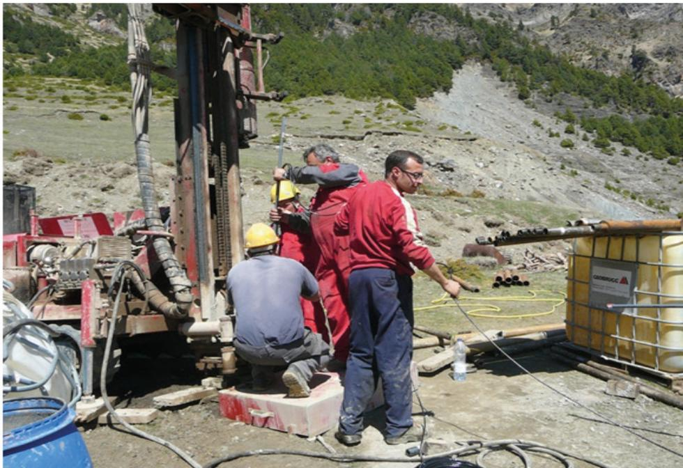
Figura 3.7: Detalle del momento de la instalación de los piezómetros de cuerda vibrante.
