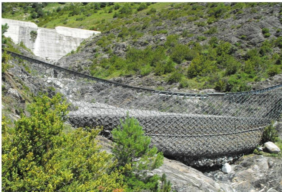
Figura 3.28: Imagen del Sistema de intercepción de flujo VX instalado en Erill tras un flujo de corriente de derrubios que ha producido el llenado de un 60% del volumen disponible. (Fuente: Propia).
