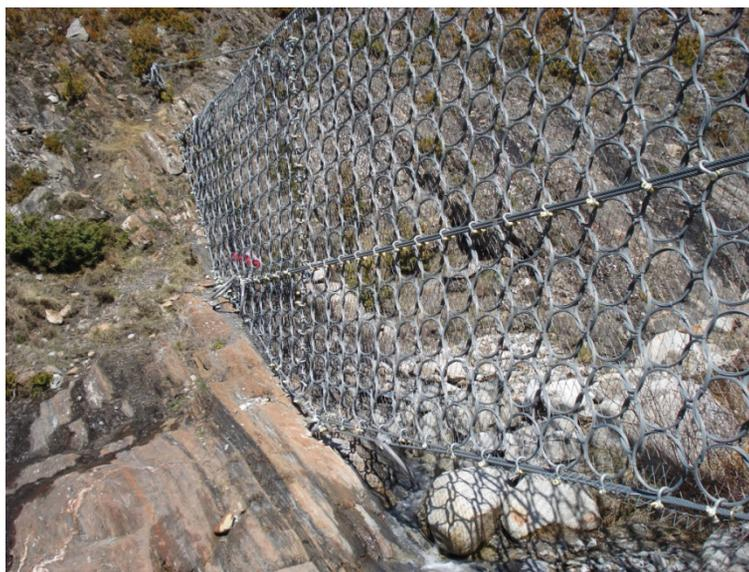
Foto 4.6: Detalle del material acumulado después del evento del 02/10/2008.
