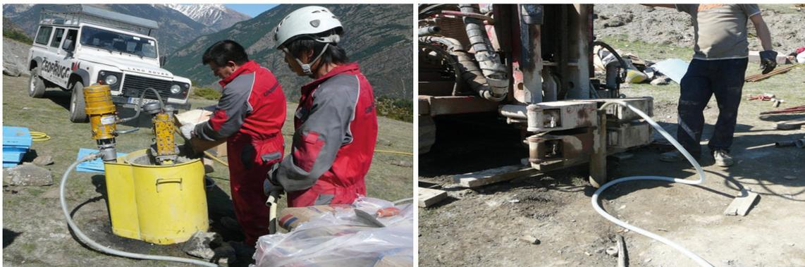
Figura 3.9: Detalle del momento de la inyección con bentonita para realizar el tapón de impermeabilización entre los diferentes niveles piezométricos. (Fuente: Propia)
