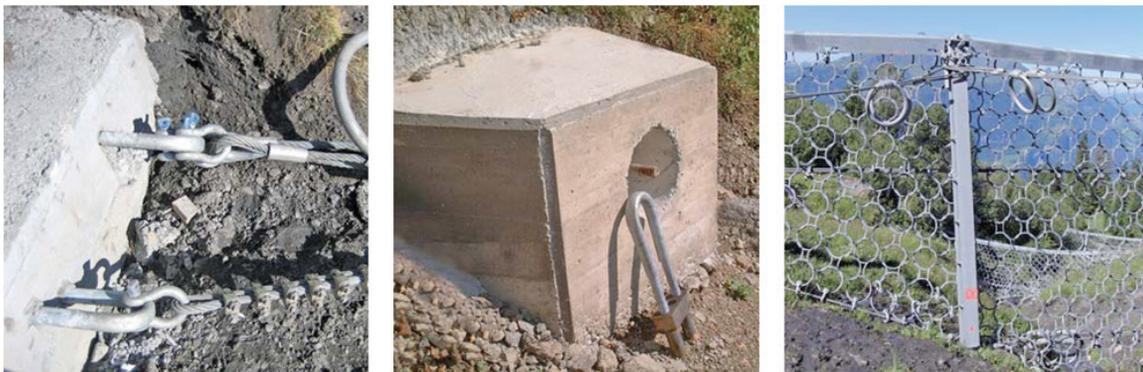
Figura 3.22: Imágenes de algunos detalles del Sistema VX o UX. De izquierda a derecha: Conexión entre los cables del Sistema y los anclajes de cable, cimentación para vincular la cabeza flexible con la barra de anclaje y poste metálico (Fuente: Geobrugg).
