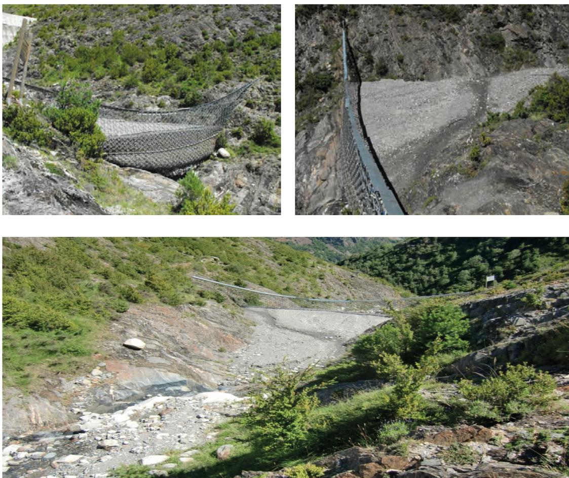
Foto 4.10: Imágenes que muestran el nivel de aterramiento de la estructura VX.
