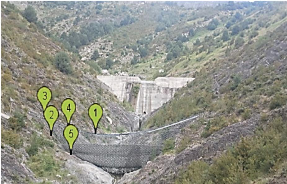
Figura 3.29: Imagen del Sistema de intercepción de flujo VX instalado en Erill con la posición de las galgas de tensión. (Fuente: Propia).
