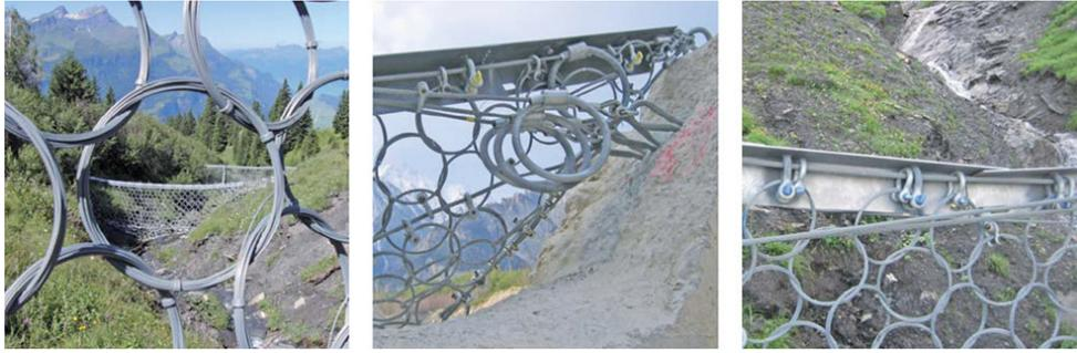
Figura 3.21: Imágenes de algunos detalles del Sistema VX. De izquierda a derecha: Malla flexible de interceptación del flujo, elementos de frenado o disipadores plásticos de energía, protección contra la abrasión (Fuente: Geobrugg).
