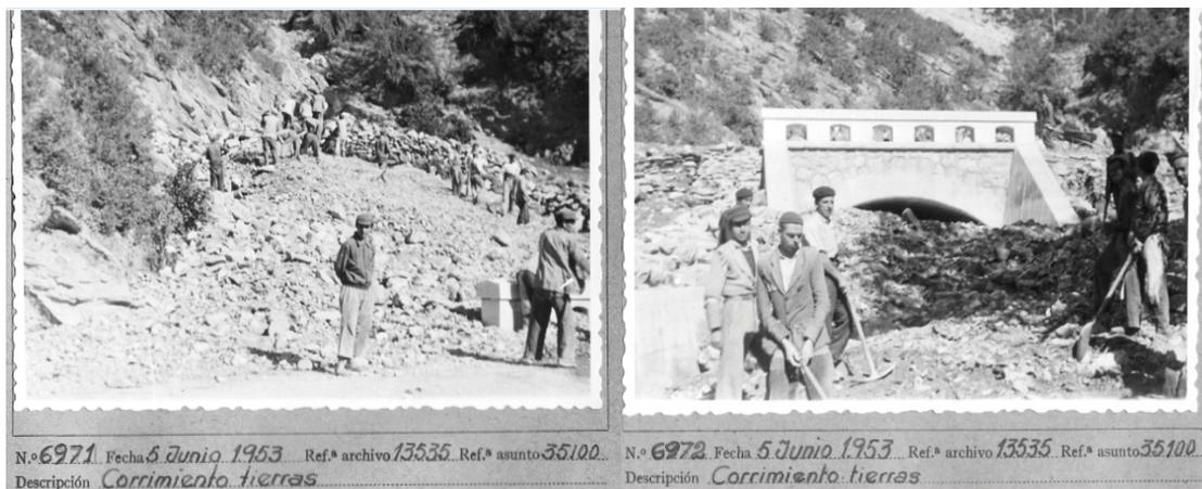
Figura 2.29: Fotos del fondo FECSA donde se observa las labores de limpieza de las obras de drenaje de la carretera en construcción.
