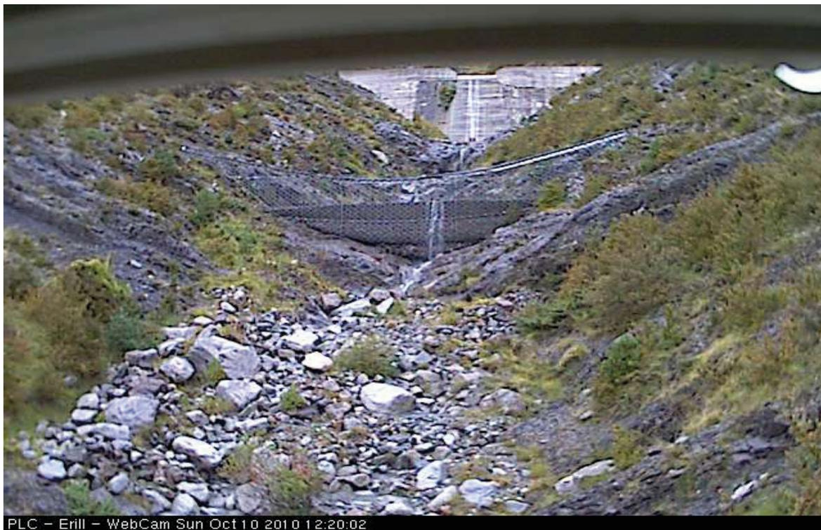
Figura 3.13: Imagen desde la cámara secundaria (webcam) de la instalación VX para la intercepción del flujo. (Fuente Propia)
