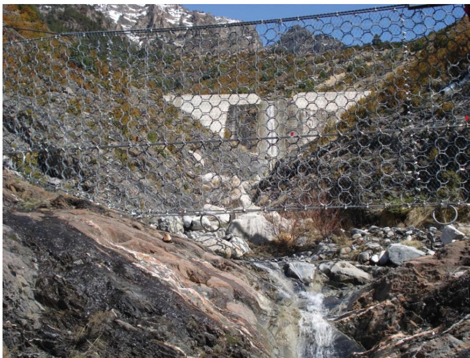
Foto 4.5: Detalle del desagüe inferior de la malla después del evento del 18/04/2008.
