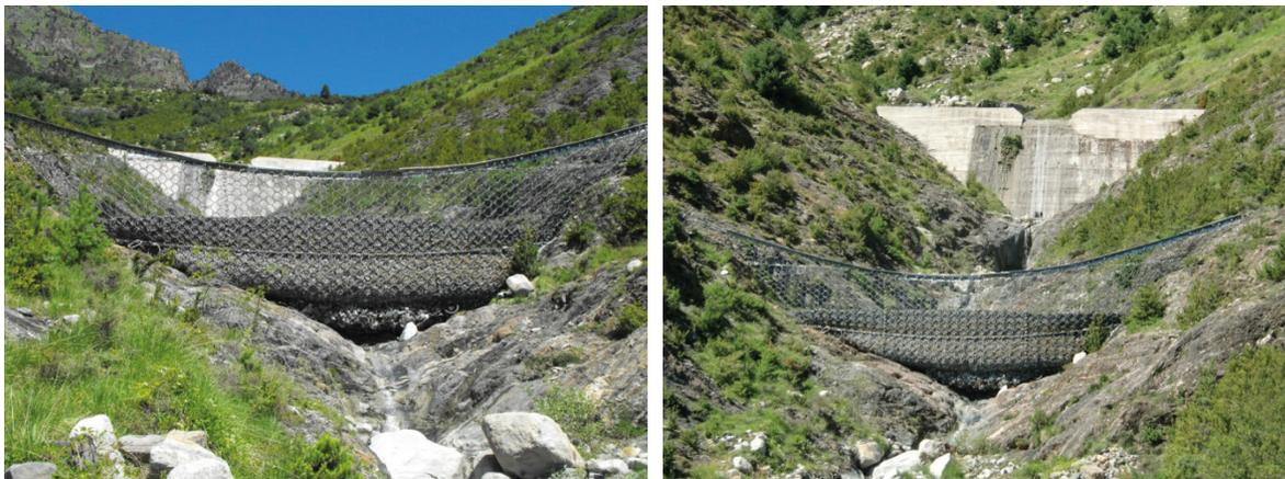
Foto 4.17: Vista completa desde aguas debajo de la estructura VX parcialmente llena.
