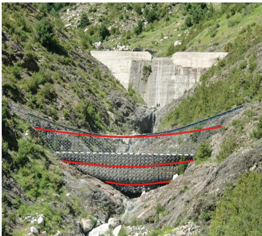
Figura 4.50: Vista frontal de la estructura VX llena hasta el 60% de su altura, destacando en rojo los tres cables C1 BASE, C2 MITAD Y C3 ALTO.
