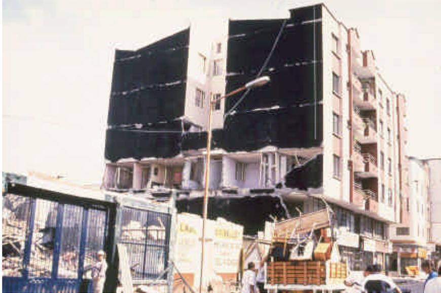
**Foto 5.5:** Caída de muros de tabiquería de fachada por flexibilidad de la estructura.
