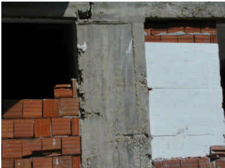
**Foto 5.9:** Estructura donde se aprecia la falta de vibrado del hormigón.
