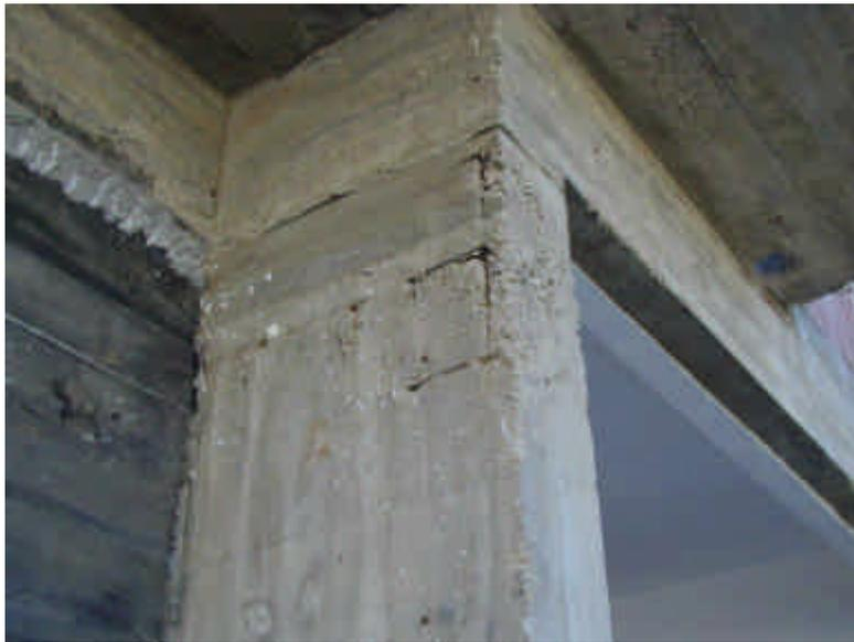
**Foto 5.8:** Estructura en construcción donde se detecta la falta de recubrimiento.
