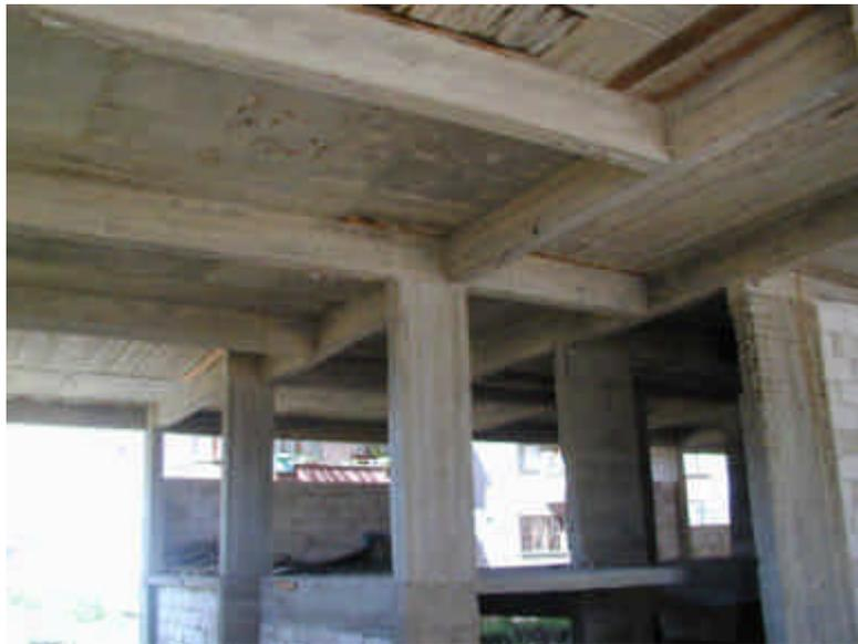
**Foto 5.10:** Mala configuración estructural de entramados que forman pórticos.
