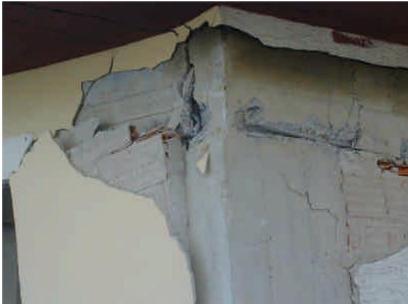
**Foto 5.11:** Deficiente detallado del refuerzo, falta de anclaje y de adherencia.
