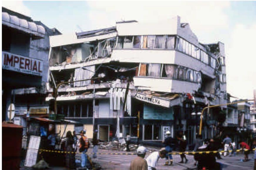
**Foto 5.3:** Edificio de hormigón armado construido sin normas sismorresistentes.
