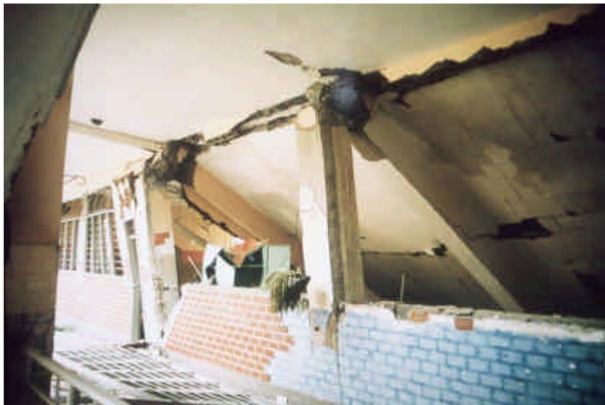
**Foto 5.6:** Fallo de nudos de unión viga-pilar por falta de refuerzo transversal.
